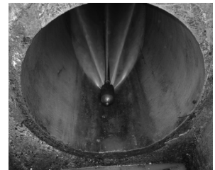
図-5 管体部土砂撤去作業
