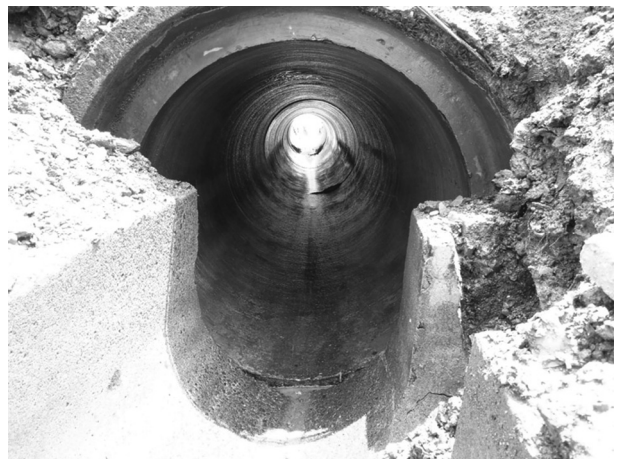
図-6 管体部完了後
