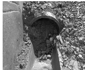
図-4 管体部着工前
