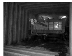
図-11 3号ゲート施工完了
