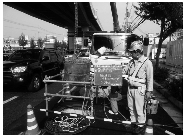
図-5 掘進機回収状況
