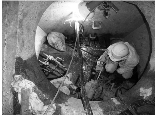
図-4 人孔内薬液注入状況
