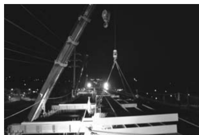
図-6 合成床版架設状況
