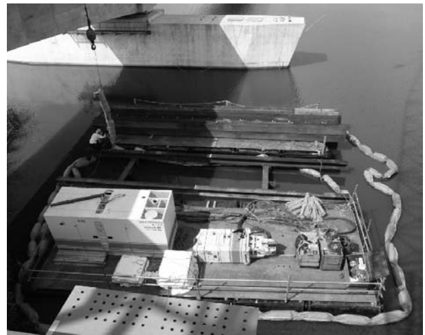
図-3 シルトフェンス設置状況
