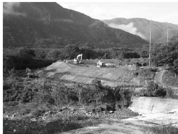
図-1 工事箇所全景
