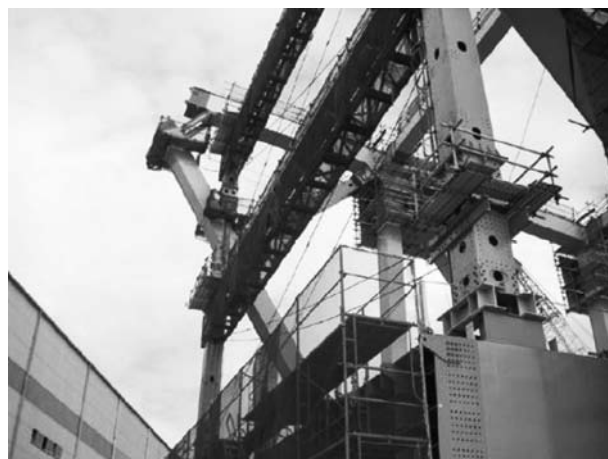
図-3 大ブロック架設用形状保持材
