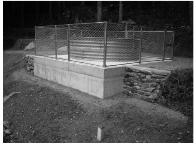
図-7 集水井完成
