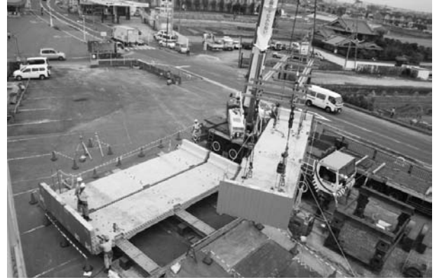
図-12 架設状況（模擬訓練）
