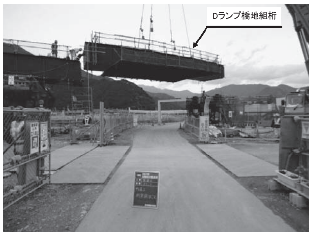
図-8 町道上の地組・架設状況
