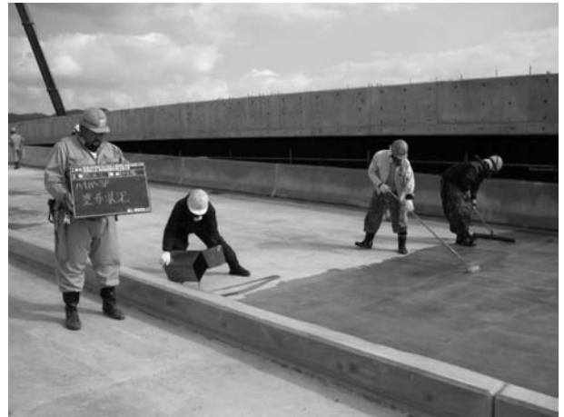
図-3 ハイパー SPの施工状況
