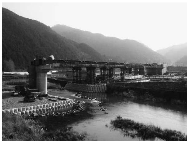
図-4 補剛桁架設完了
