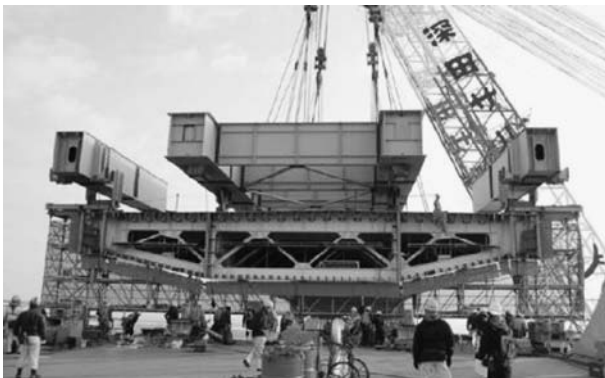
図-8 閉合部箱桁の大ブロックの架設（断面）
