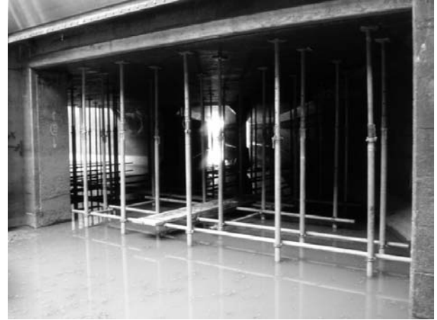
図-11 残置部分の補強
