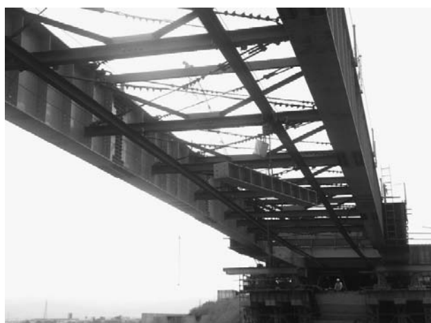
図-3 機材運搬状況
