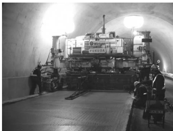
図-9 コンクリート舗装打設状況
