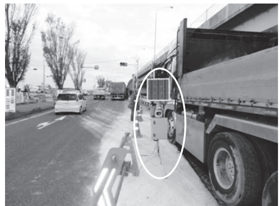
図-1 カーデル設置状況
