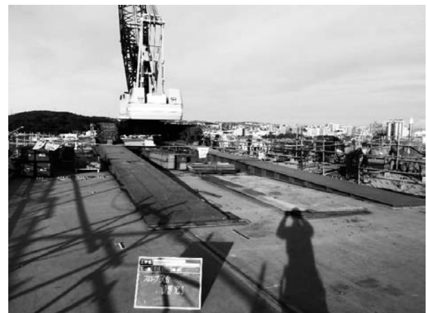
図-6 クレーン用スロープ架台
