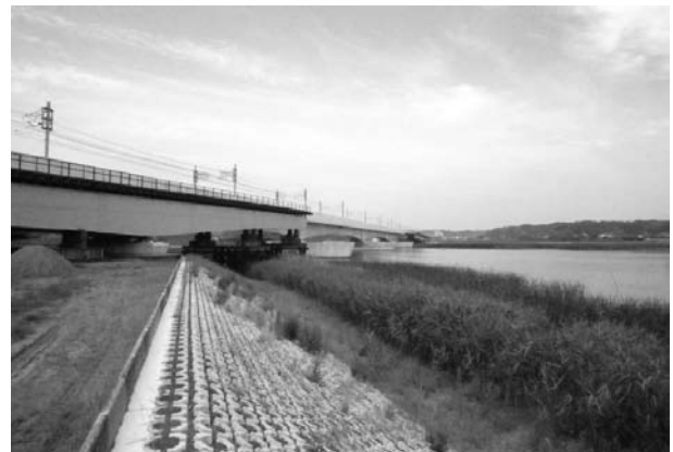
図－2 着手前現場全景
