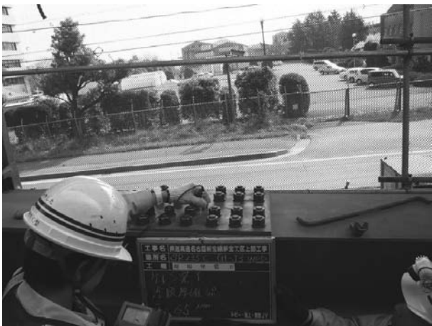
図-2 塗膜厚測定（現場塗装前）
