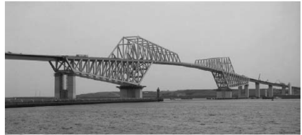
図-9 架設完了後の全景
