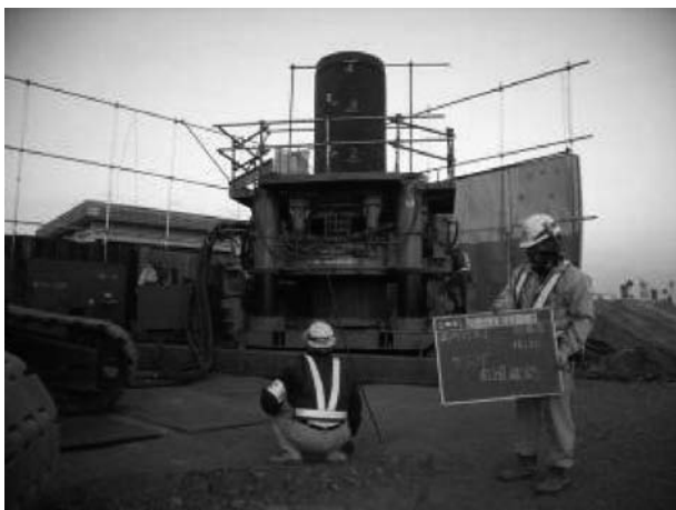
図-4-1 下げ振りによる鉛直確認
