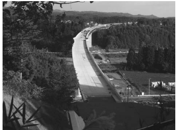
図-7 床版、壁高欄完成
