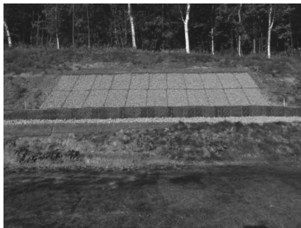
図-6 復旧工事完成
