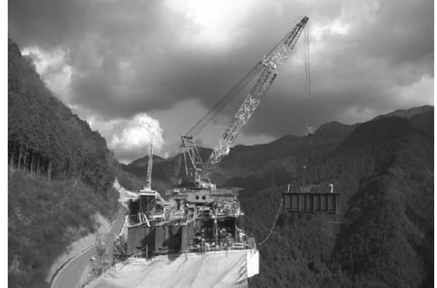
図-12 トラベラクレーンによる架設状況
