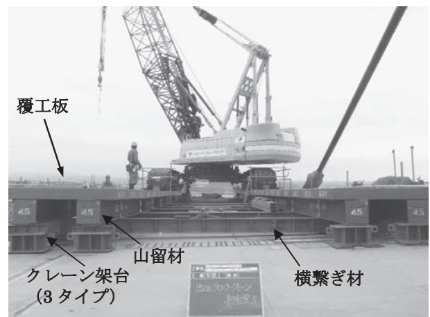
図-5 クレーン架台
