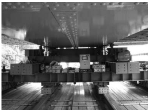
(c) リアルタイム計測設備
