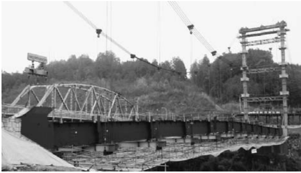
図-6 補剛桁架設状況
