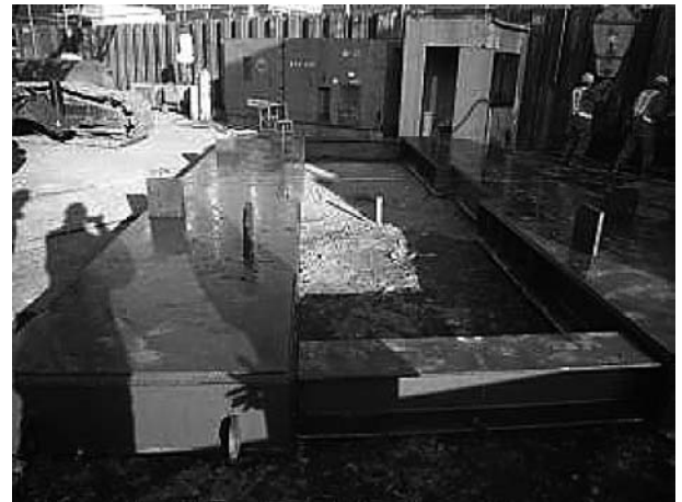
図-3-1 掘削機専用架台
