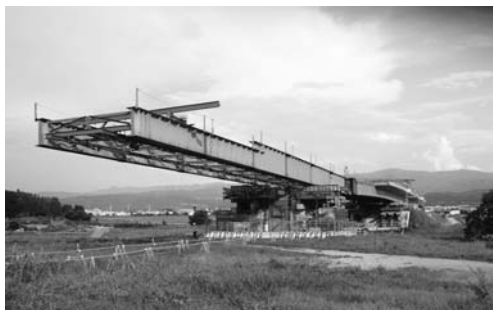
図-3 合成床版を搭載した送出し架設
