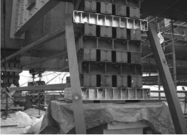
図-8 サンドル固定用鋼材の増設
