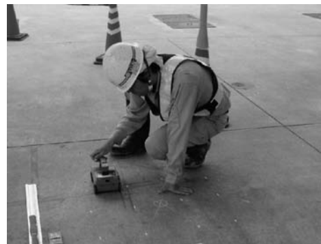
図-3 鉄筋探査状況
