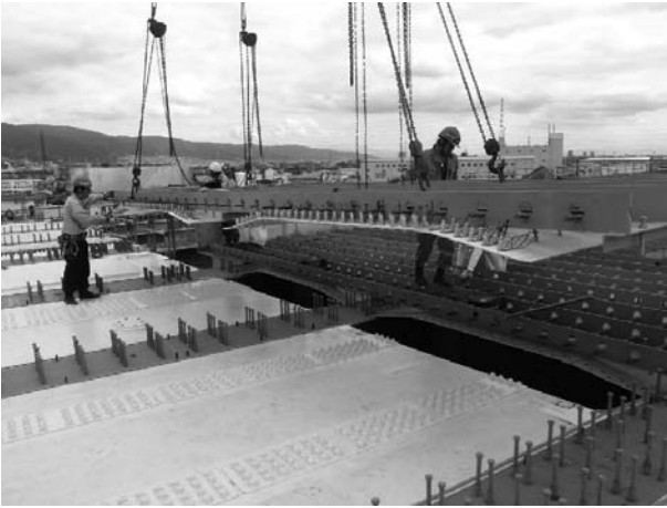
図-6 床版パネル架設状況
