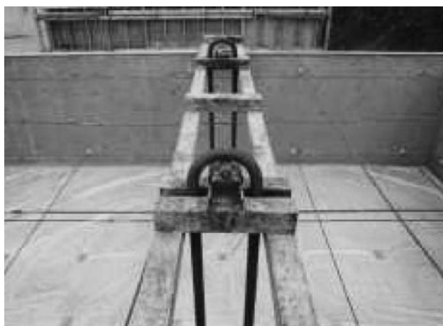
図-3 吊アンカー取付け用専用治具
