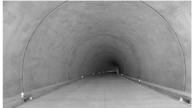
図-5 覆工コンクリートの出栄え
