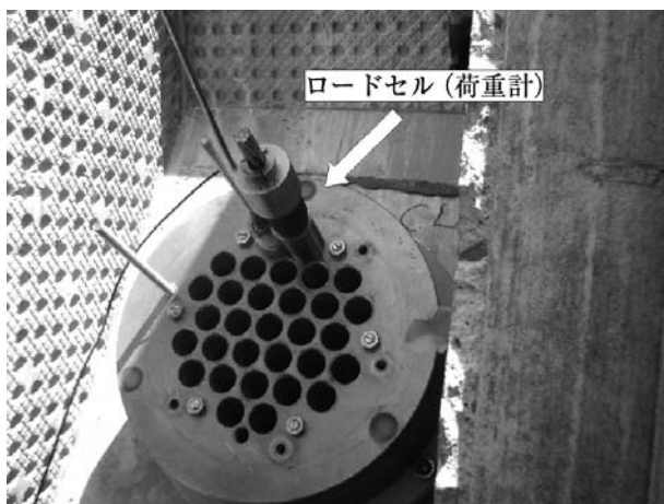
図-5 ロードセル設置状況
