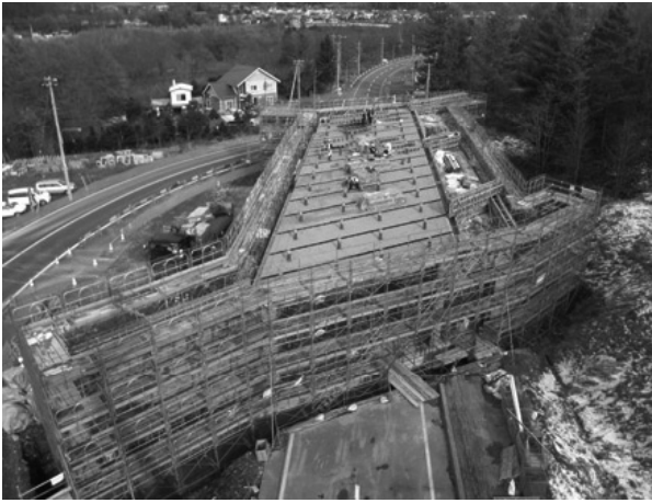
図-3 施工中全景
