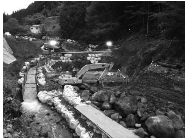
図-9 締切設置完了状況
