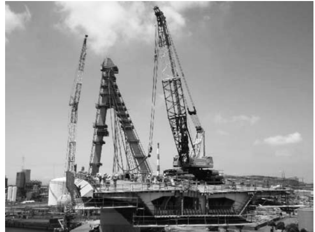
図-3 施工状況（ケーブル保護管）
