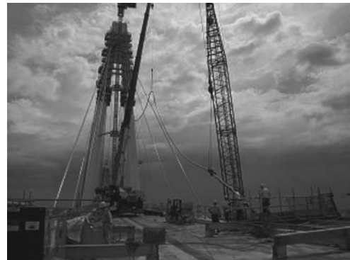
図-6 主ケーブル架設状況
