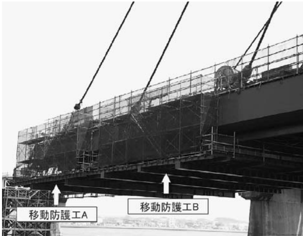
図-13 移動防護工（側径間）
