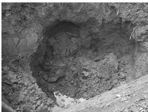
図-3 湧水・崩土箇所確認
