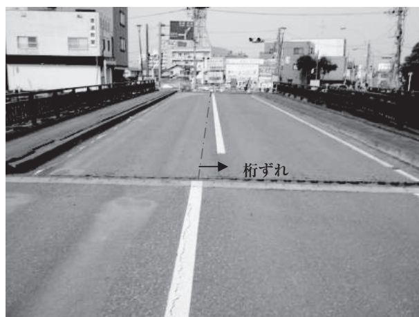
図-1 桁のずれ（第3径間）
