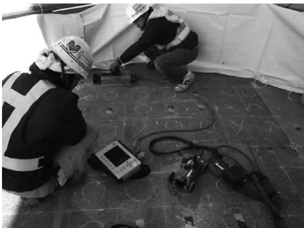
図-5 地中探査状況
