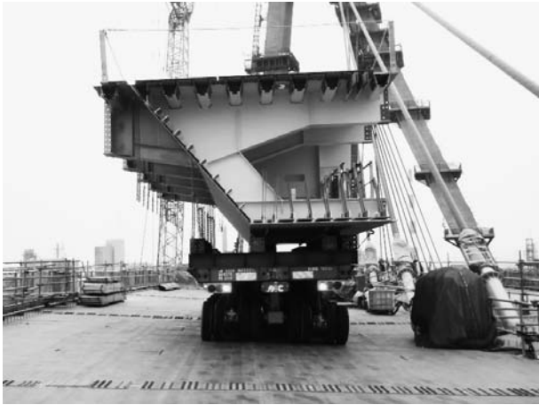
図-7 鋼桁運搬状況（外セル）
