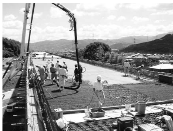
図-3 床版コンクリート打設状況
