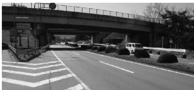
図-2.2.3 工区後半の曲線部
