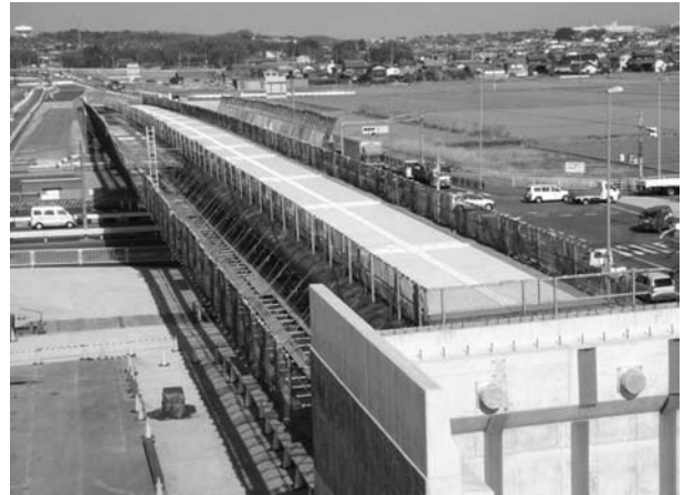
図-4 架設完了全景写真図
