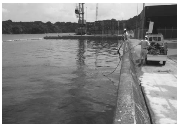
図-4 潜水調査状況
