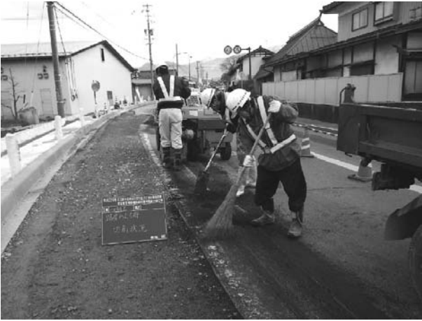
図-5 既設道路わだち切削状況
