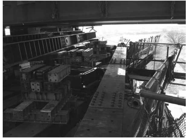
図-7 工事用梁の落下状況
