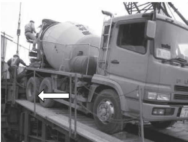
図-7 本体とスロープとの段差
