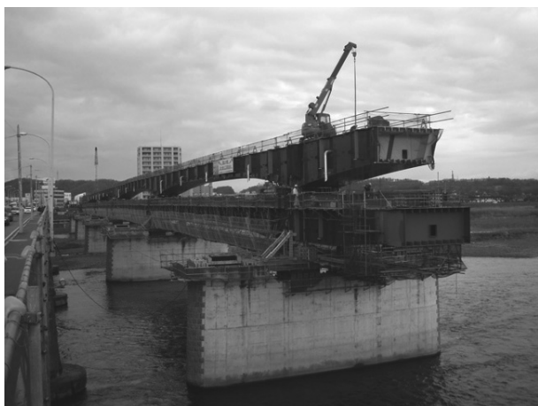
図-4 G1桁送出し
