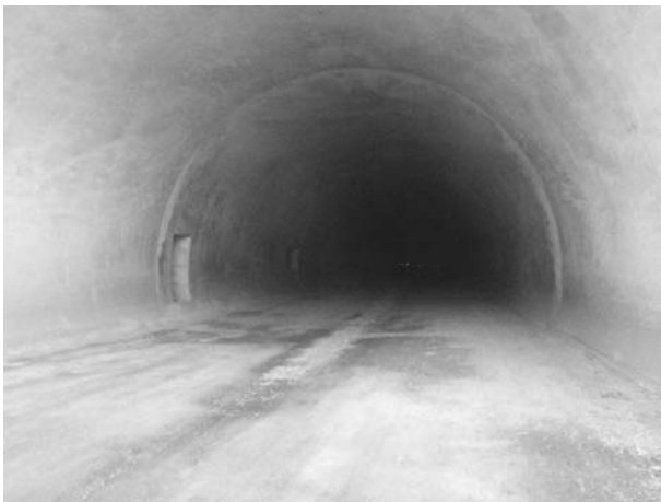
図-1 着手前の現場状況
