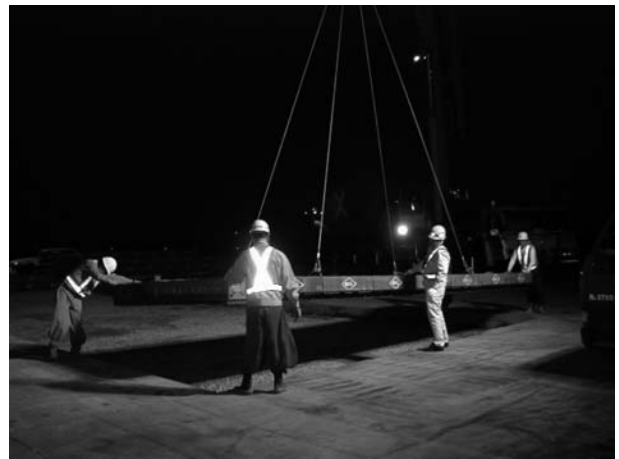
図-3 覆工板設置状況
