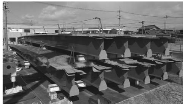
図-3 主桁部材地組立
