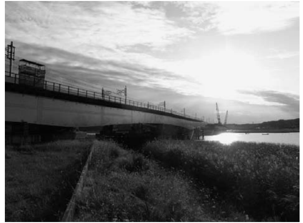
図-9 現場完成全景
