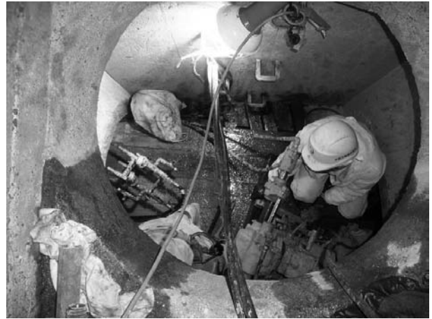
図-4 人孔内薬液注入状況
