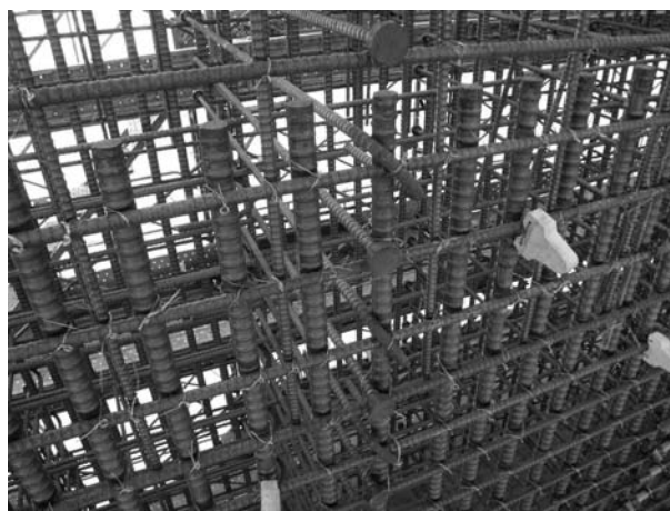
図-4 鉄筋組立完了
