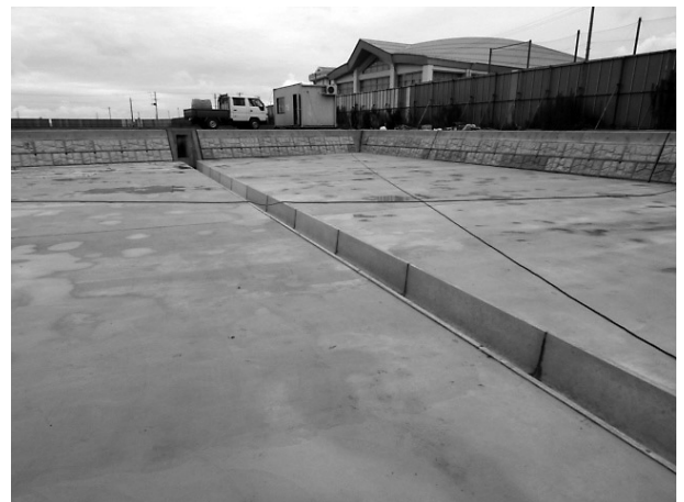
図-1 調整池底部に設置したベンチフリューム
