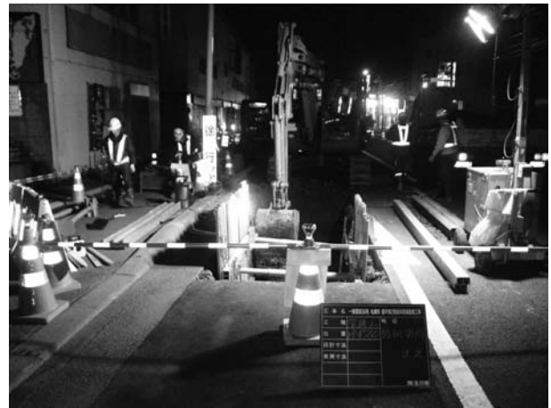
図-5 管路掘削状況
