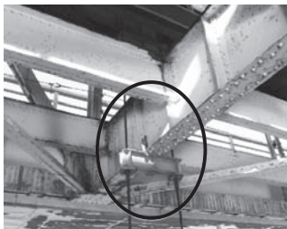
図-7 吊下げ設備
