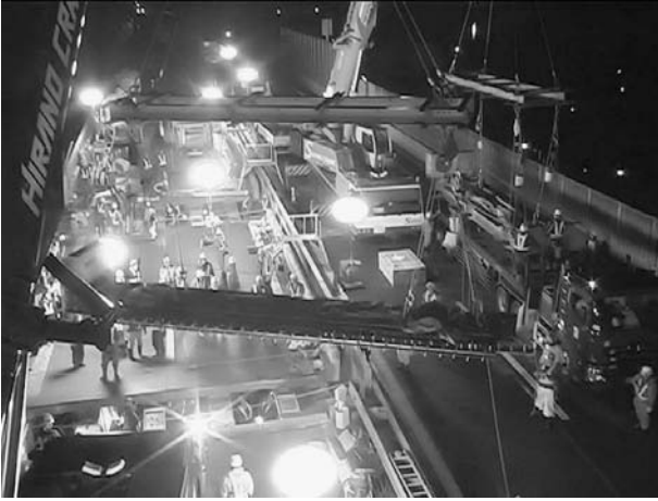
図-11 2班同時施工
