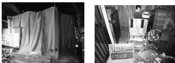
図-9 プラント閉塞状況 図-10 騒音・振動計計測
