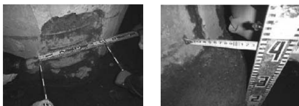
床付=500付近礫質土確認 (下部コブ状部分)
