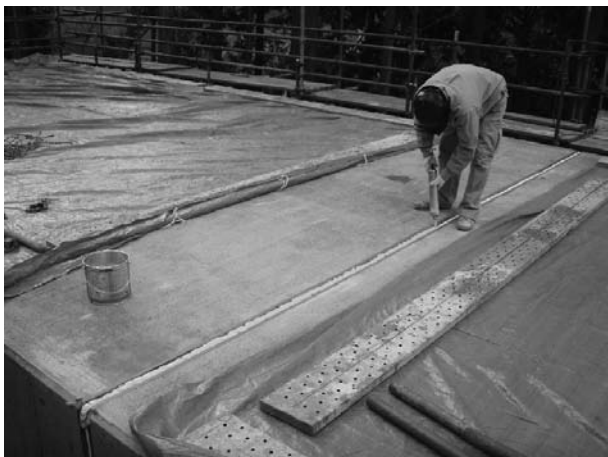
図-8 Vカット目地充填状況
