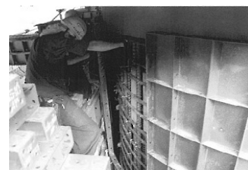
図-4 鋼製型枠の設置状況
