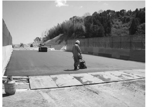
図-3 橋梁部養生状況
