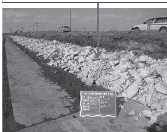
図-5 旧コンクリート水路解体完了
