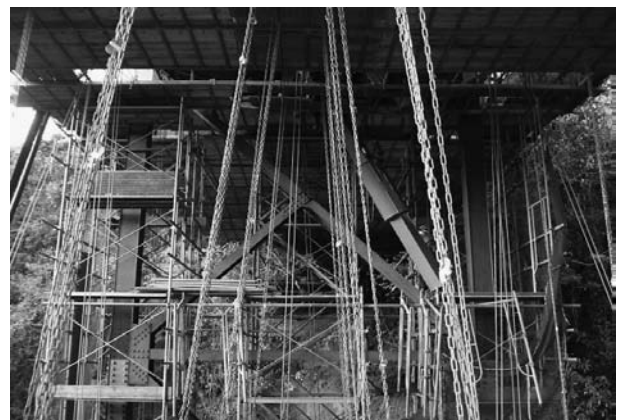
図-6 耐震ブレース取替状況 (STEP-4)
