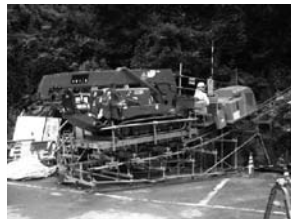
図-2 仮設モノレール
