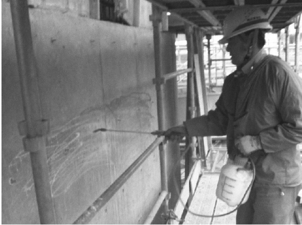
図-6 塗膜養生剤塗布状況
