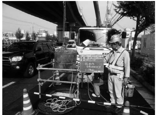
図-5 掘進機回収状況
