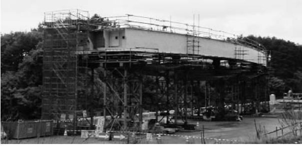
図-2 地組立完成
