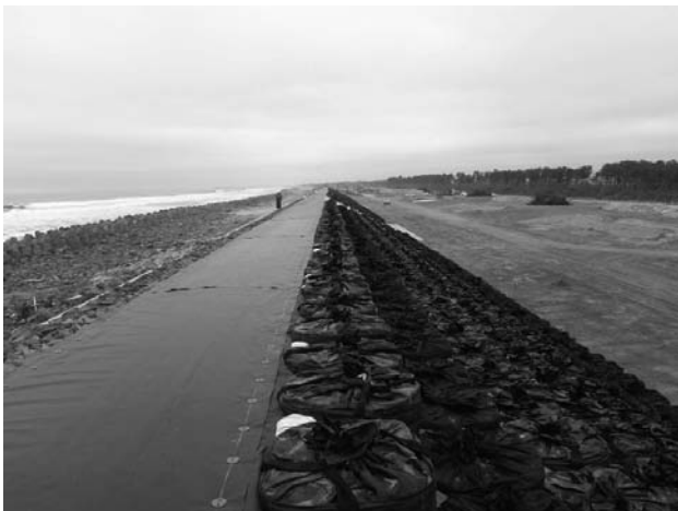
図-8 竣工時写真
