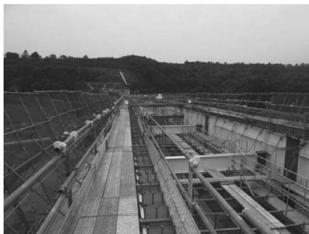
図-1 床版施工前
