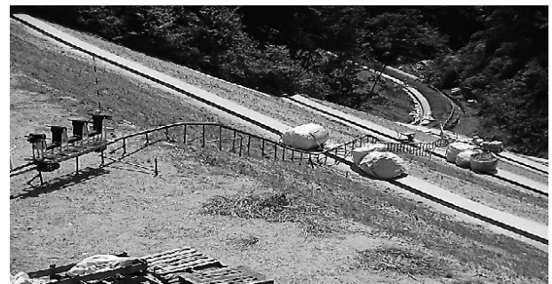
図-2 モノレール設置状況
