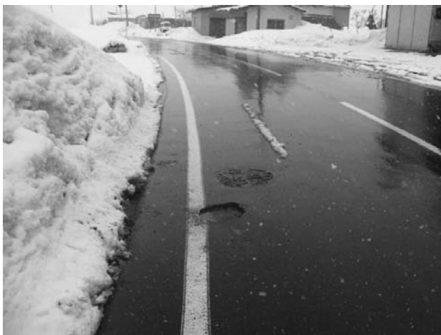
図-1 降雨（雪）のポットホール発生状況
