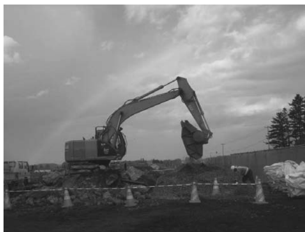
図-3 再生骨材製造状況
