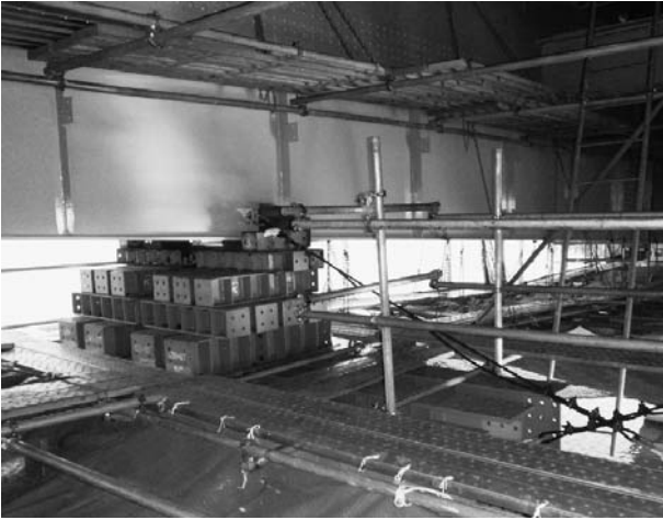
図-8 サイドストッパーおよびラッシング状況
