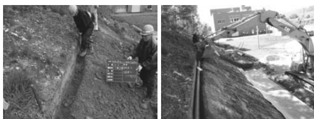
図-3 人力掘削・暗渠管設置
