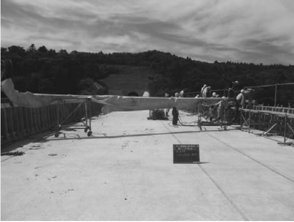
図-6 壁高欄コンクリート打設状況
