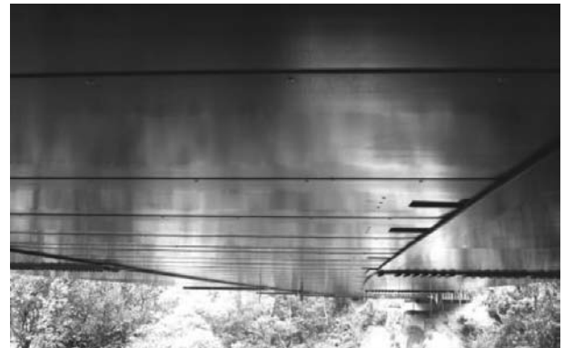
図-4 設置後の FRP 防護板下面
