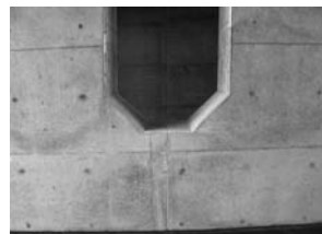
図-9 誘発目地の設置状況
