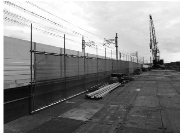
図-6 営業線側の防護柵設置状況
