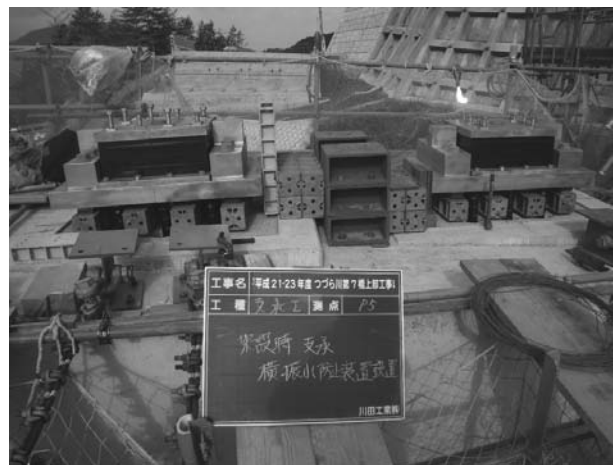
図-9 支承横振れ防止装置
