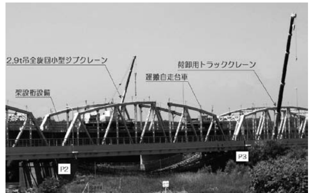
図-10 桁撤去状況 (P2～P3)
