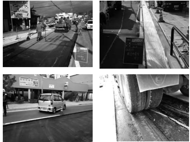
図-5 既存街路を汚す事無く環境配慮した施工状況
