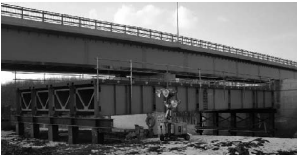
図-13 栈橋設置完了写真
