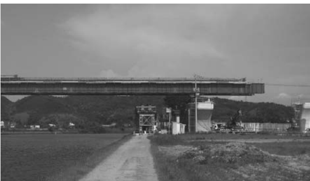
図-6 河川管理路上のベント
