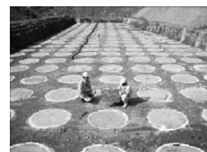
図-7 深層改良完了
