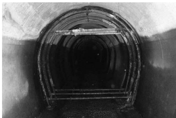
図-1 仮補強状況
