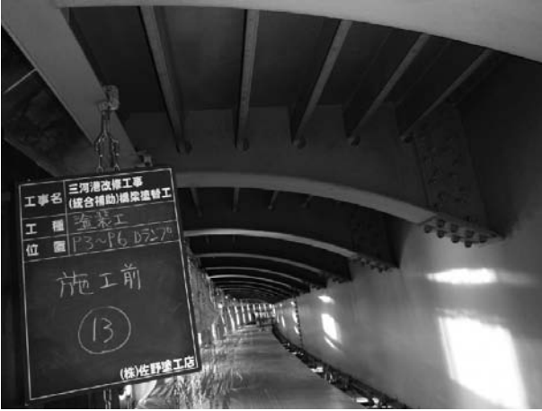
図-5 明り取り・ホワイトロールシート養生設置
