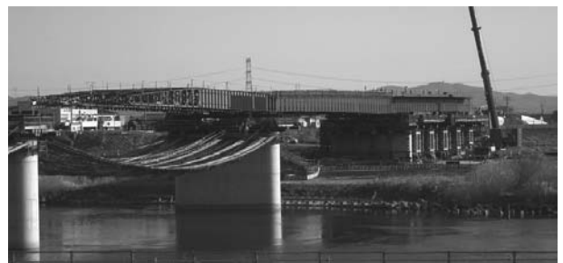
図-2 送出し架設状況
