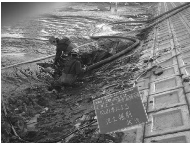
図-10 大型吸引車と人力での掘削
