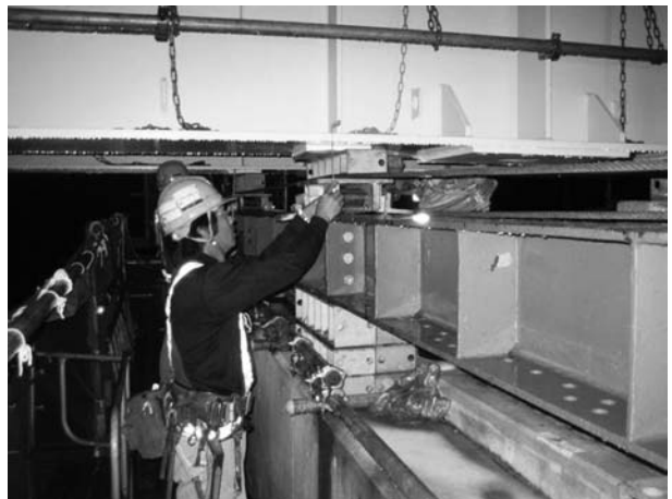
図-4 横取り状況（その2）
