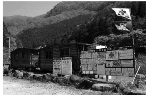
図-4 ログハウス現場事務所
