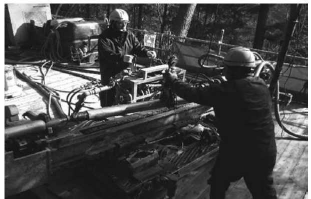
図-6 取付け状況
