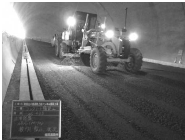
図-4 上層路盤における情報化施工
