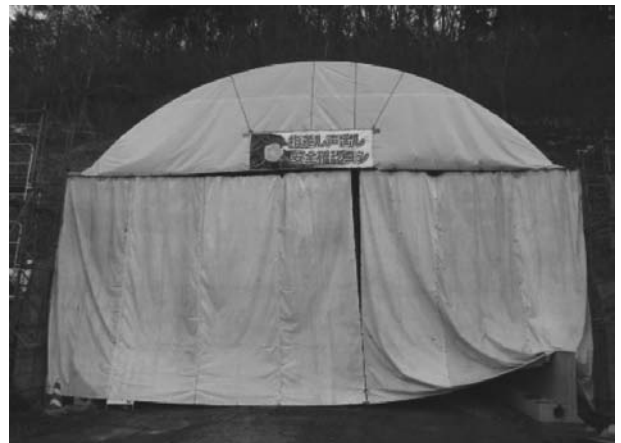
図-4 トンネル坑口の閉鎖 (閉鎖時)
