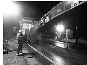
図-5 粉塵防止対策ネット設置
