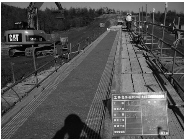
図-1 ハイパーネット敷設状況
