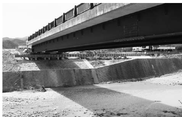
図-6 横引き作業状況
