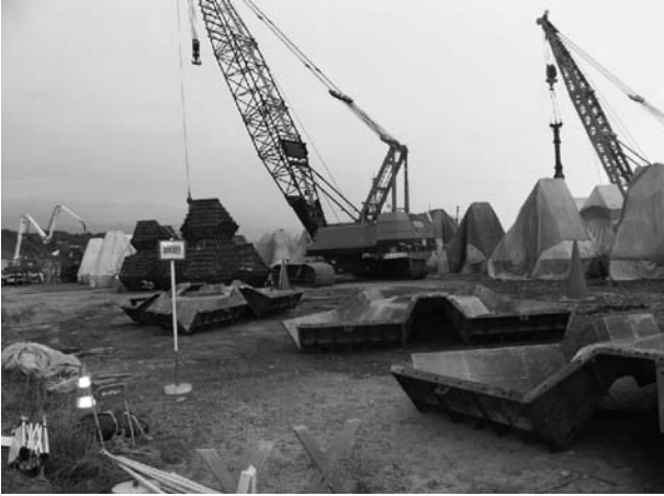
図-1 作業区域明示状況－その1
