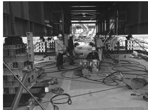
図-5 揚重機縦送り状況
