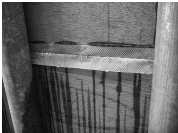
図-4 余剰水排水状況
