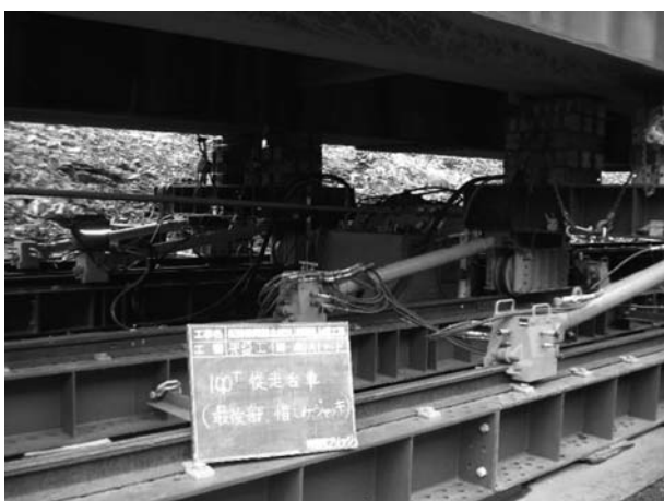
図-7 水平ジャッキ設備
