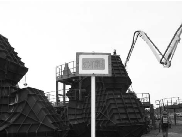
図-2 作業区域明示状況－その2
