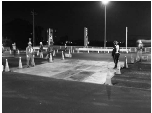
図-3 敷板設置状況
