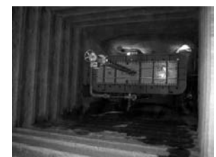
図-11 3号ゲート施工完了
