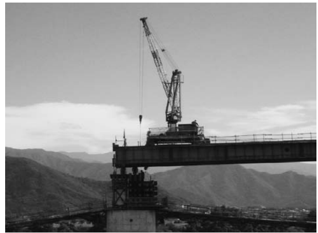
図-8 手延べ機上の移動式クレーン
