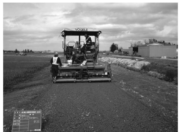
図-4 耕作道路 砂利敷均し状況
