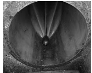
図-5 管体部土砂撤去作業
