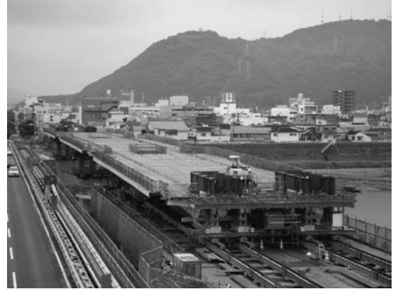
図-2 送出し架設状況
