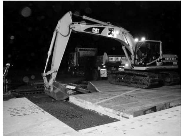
図-2 アスファルト撤去状況
