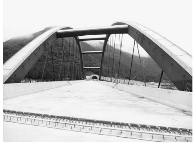
図-7 床版・高欄コンクリート施工完了
