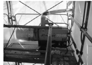
図-4 煙突による排気状況
