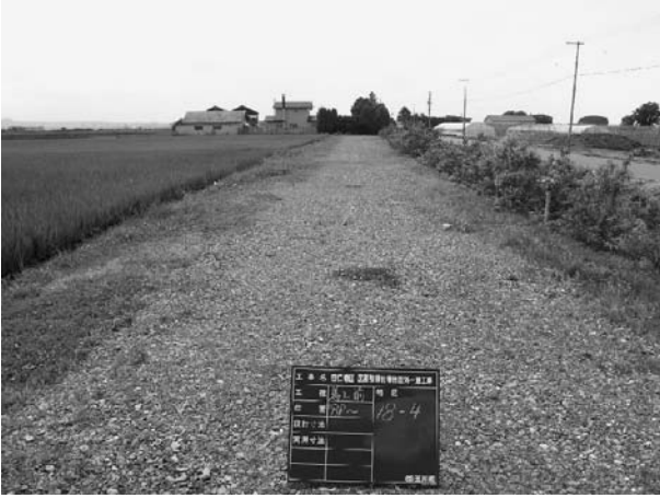
図-5 着手前 現況
