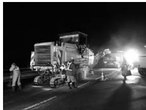
図-4 深掘切削機施工状況
