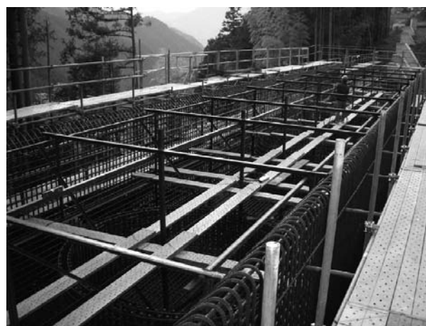
図-4 鋼材配置完了
