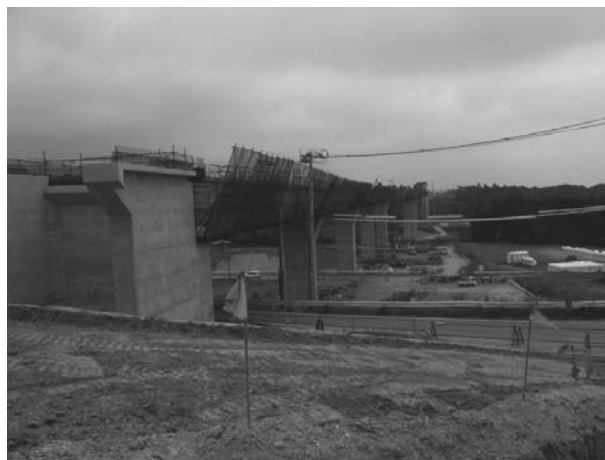
図-2 施工前（起点方より）
