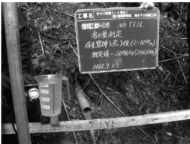
図-4 横ボーリング完了後での排水状況
