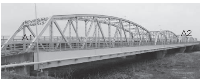
図-2 撤去前全景写真 (A1～A2)
