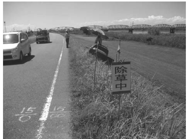
図-2 法面での機械刈状況
