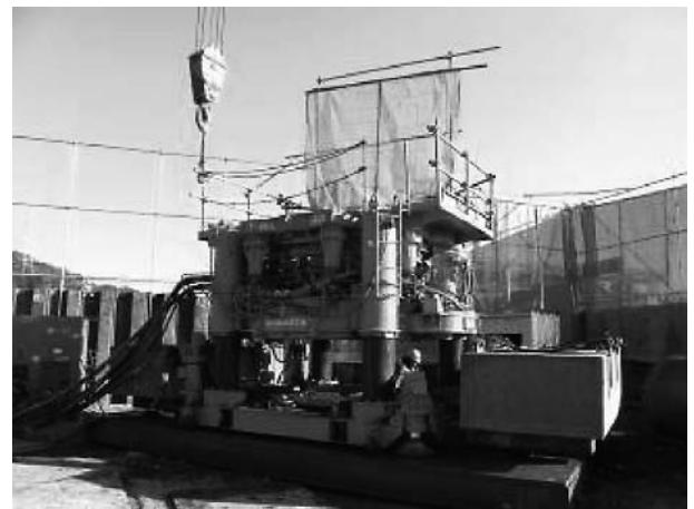
図-3-2 掘削機セット完了
