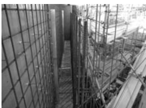
図-8 誘発目地の設置状況
