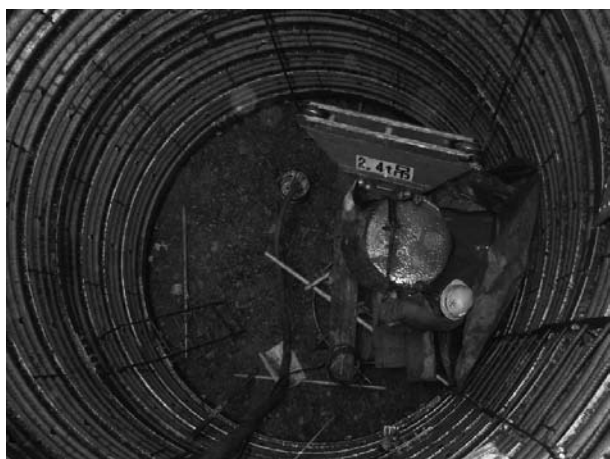
図-4 裏込めモルタル注入
