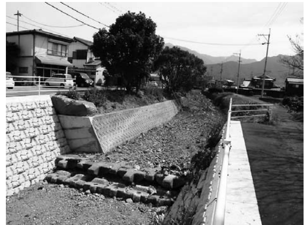
図-2 着工前状況写真
