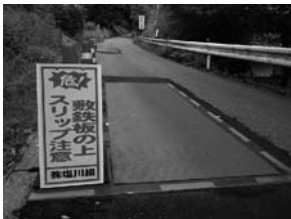
図-1 埋設物の養生
