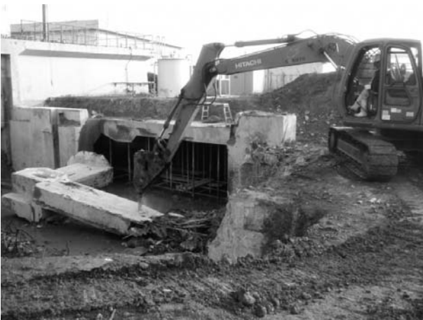
図-10 ワイヤソー切断後破碎状況
