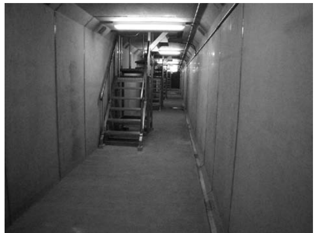
図-5 地下通路の完成
