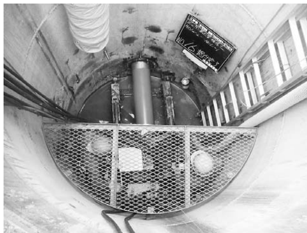
図-3 立坑内待避スペース確保
