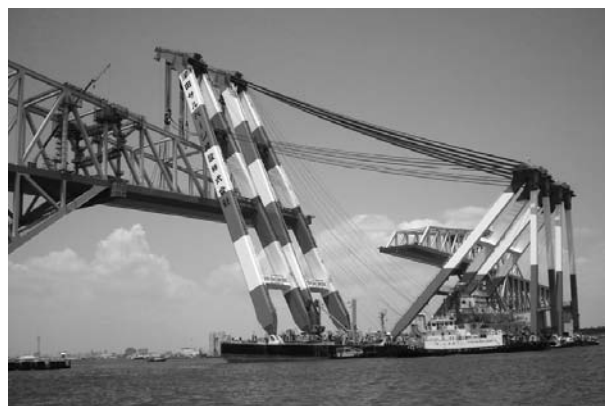
図-6 トラス部大ブロックの架設
