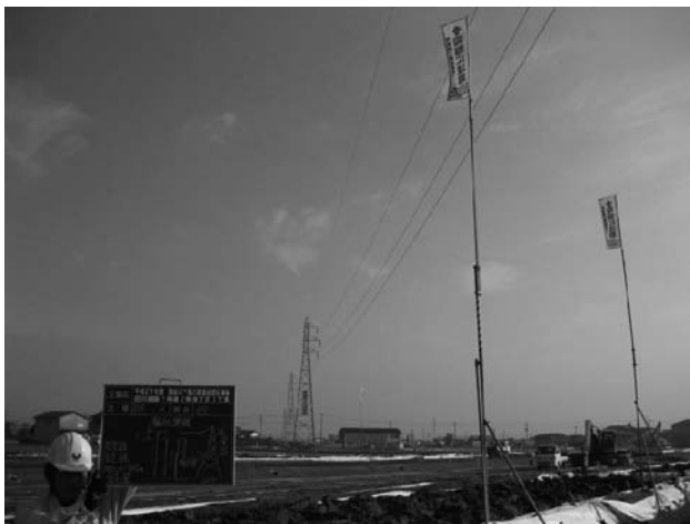
図-8 離隔高さ明示旗設置
