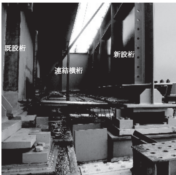
図-8 現地施工状況 (工事 A)
