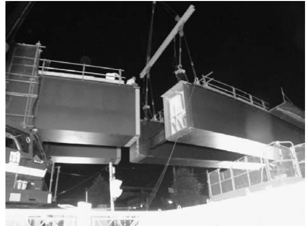
図-4 2主桁連結時の仕口合せ
