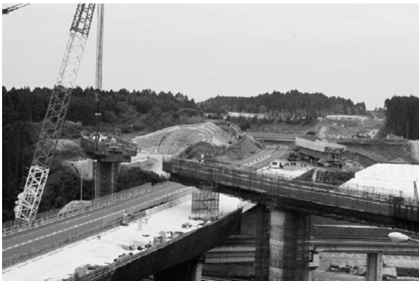
図-4 大ブロックの地組立状況
