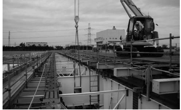
図-6 二次部材取付状況
