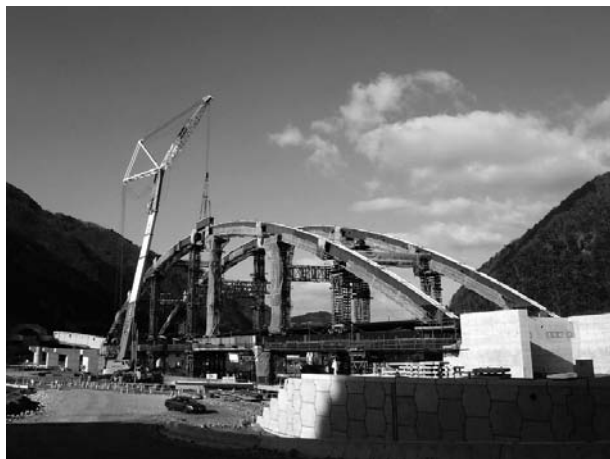
図-5 アーチ架設状況
