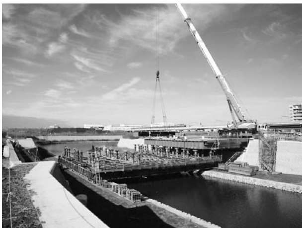
図-3 架設状況 (A2側)
