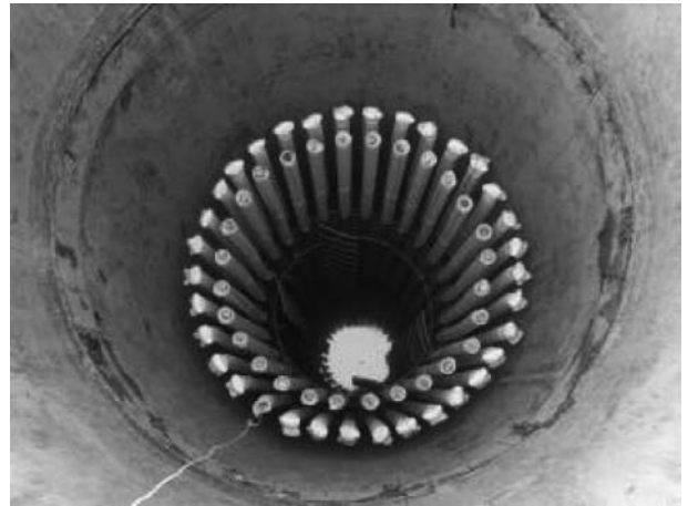
図-5 鉄筋建込完了
