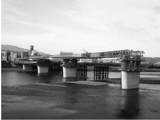
図-2 送出し架設状況
