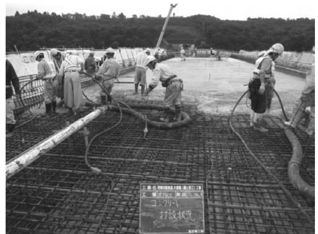
図-5 床版コンクリート打設状況
