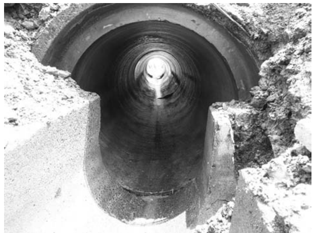
図-6 管体部完了後
