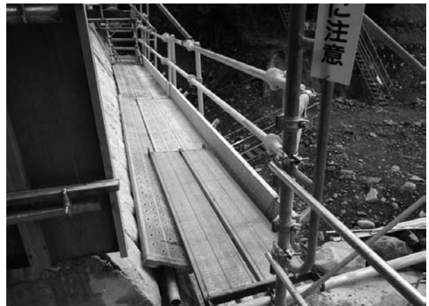
図-8 足場の隙間養生状況
