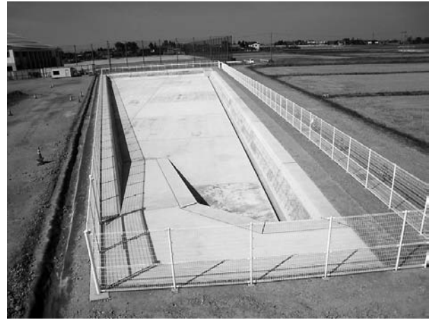
図-4 調整池全景
