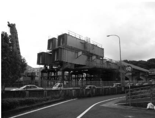
図-4 桁上地組立状況
