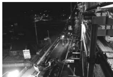
図-5 クレーン据付状況
