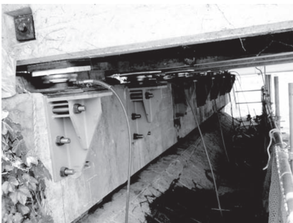
図-6 A2橋台側ジャッキ設備
