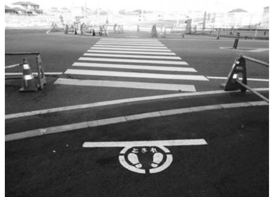
図-4 路面表示状況
