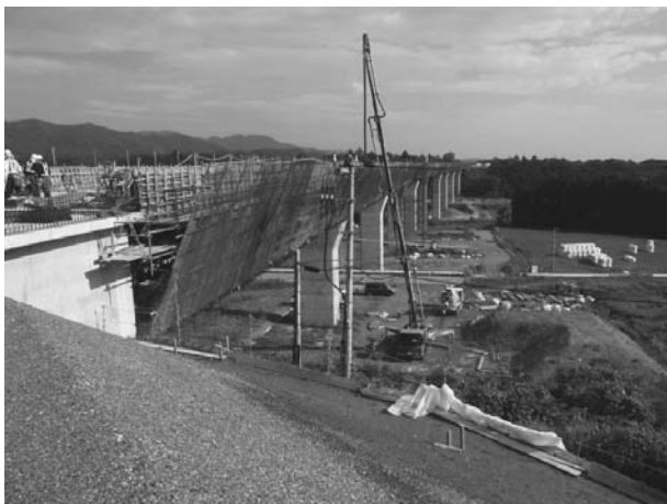
図-3 圧送試験状況
