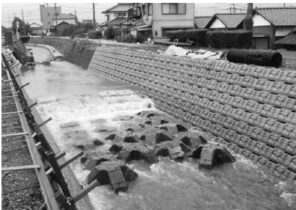
図－4 仮設護床工状況写真
