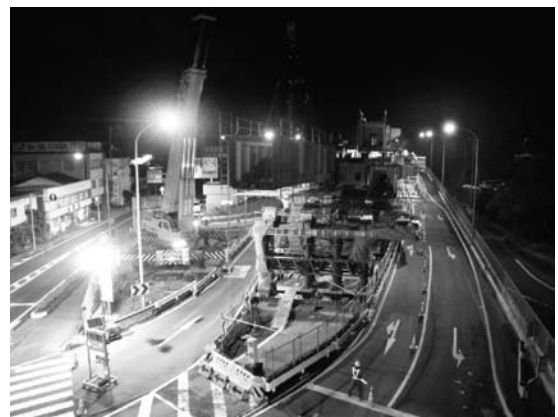
図-5 夜間架設状況
