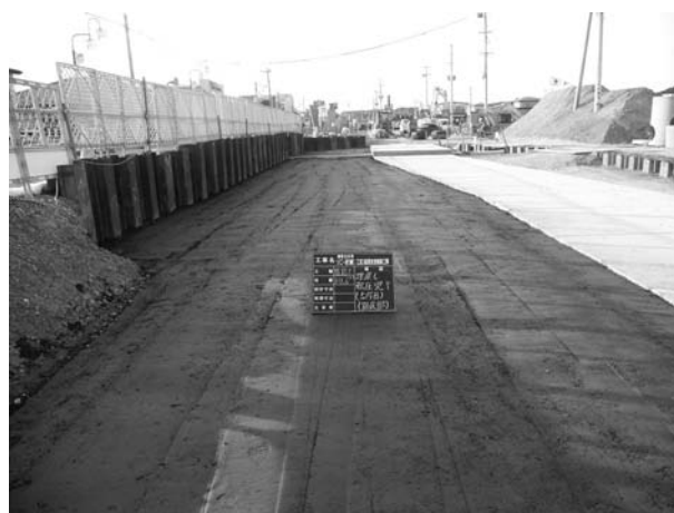
図-3 付加土利用による路床盛土
