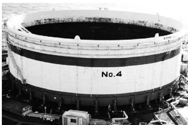
図-2 タンクリフティングサポートの使用例
