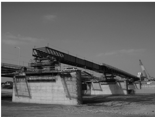
図-3 G2桁送り出し (SP3到達)
