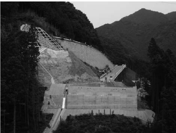
図-1 工事施工箇所全景
