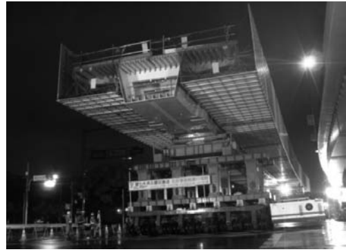
(b) 送り出し架設中
