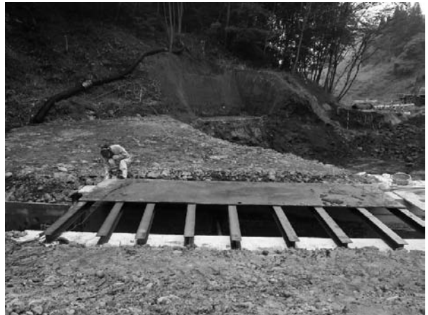
図-6 仮栈橋設置 H鋼+敷き鉄板
