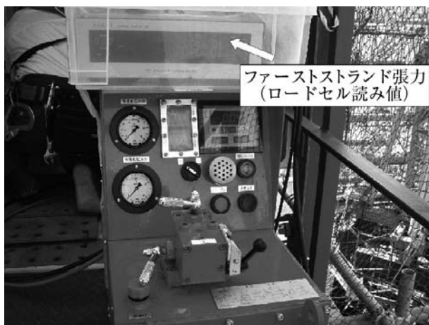
図-6 ロードセル測定値表示状況
