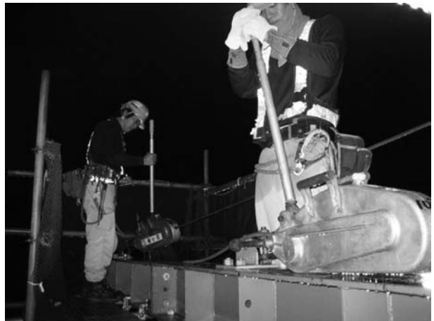
図-3 横取り状況（その1）
