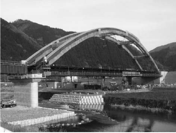
図-6 ベント撤去完了・支点支持状況
