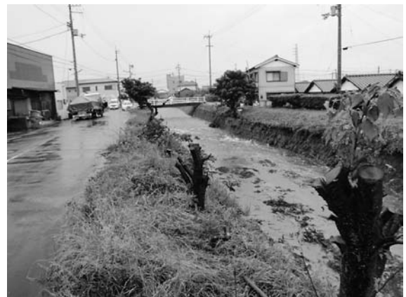
図-3 降雨時状況写真
