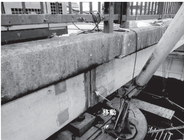
図-9 桁回転横移動完了
