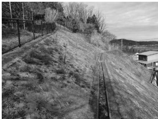
図-4 コケ緑化施工地
