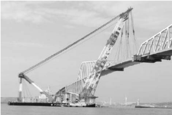
図-7 閉合部箱桁の大ブロックの架設（側面）
