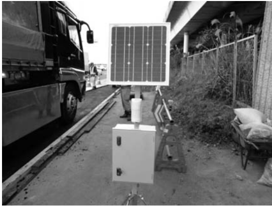
図-2 カーデル設置状況（感知機側）
