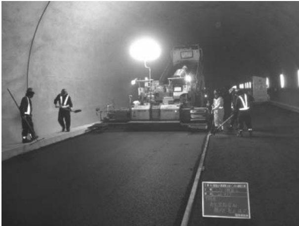
図-5 中間層の施工状況
