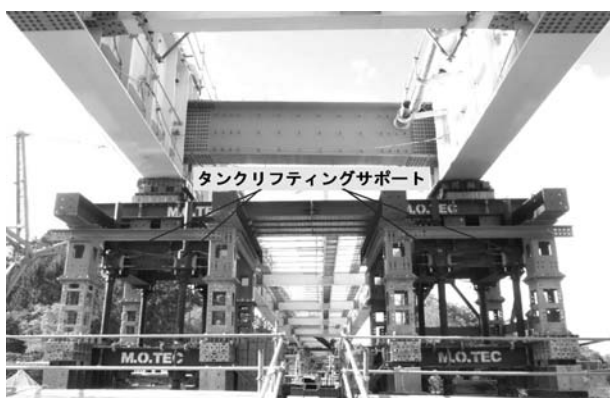
図-4 タンクリフティングサポートによる降下設備
