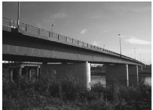
図-9 石下橋完成
