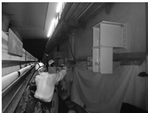
図-6 ダンパー取付け状況
