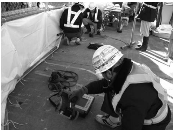
図-4 コンクリート内部探査状況
