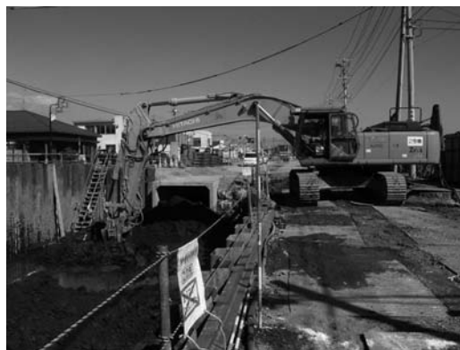
図-1 攪拌混合改良状況
