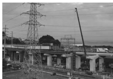
図-4 合成床版仮置き状況
