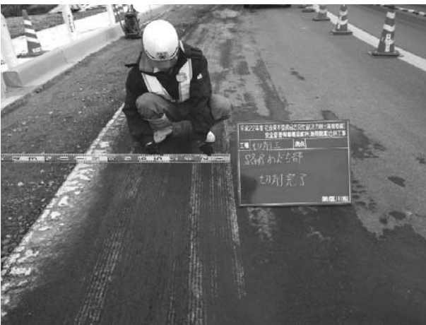
図-6 切削によりわだち掘れの解消
