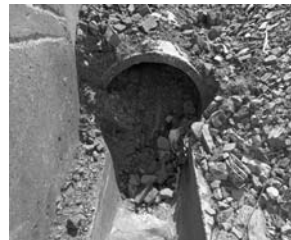
図-4 管体部着工前
