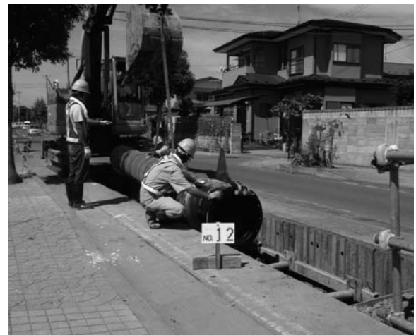
図-1 片側一車線箇所での水道管の布設状況
