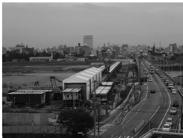
図-5 送り出しヤード全景
