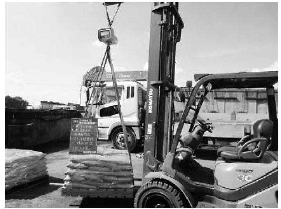
図-3 研削材の計量積載状況
