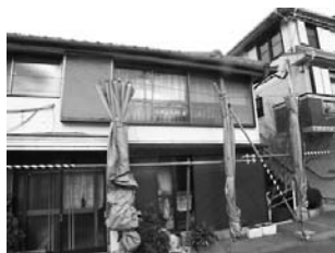
図-4 シート養生時（裾部緊縛）
