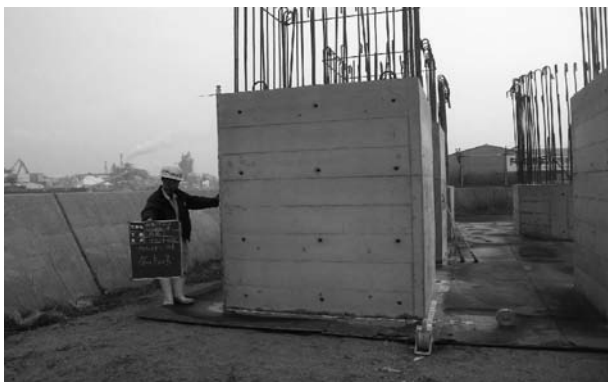
図-2 製作出来形
