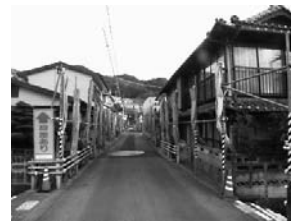
図-1 シート養生状況
