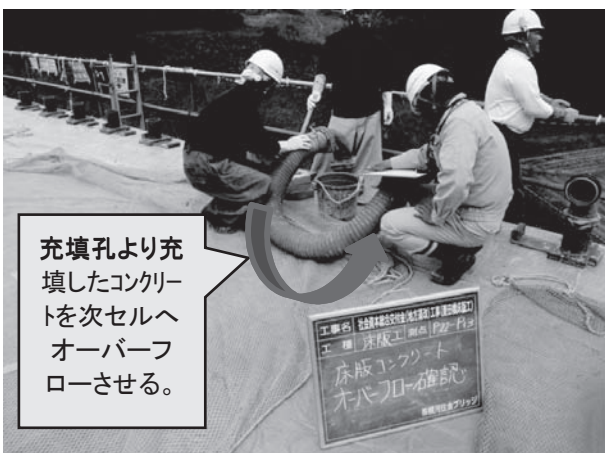
図-3 コンクリート充填状況（排出孔）
