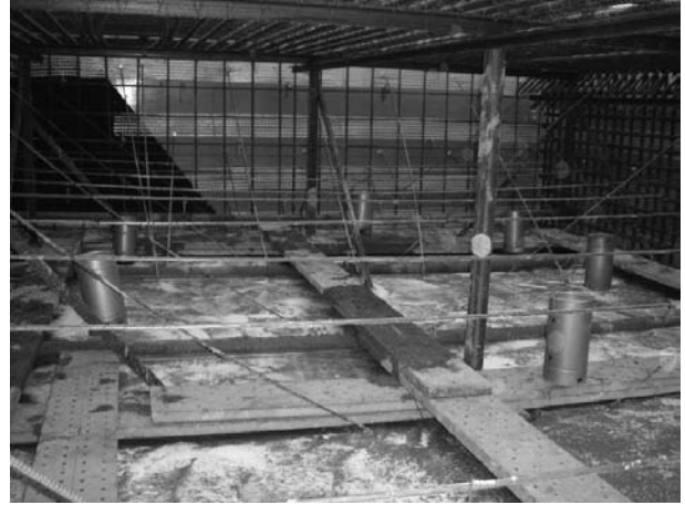
図-5 打継処理剤散布状況
