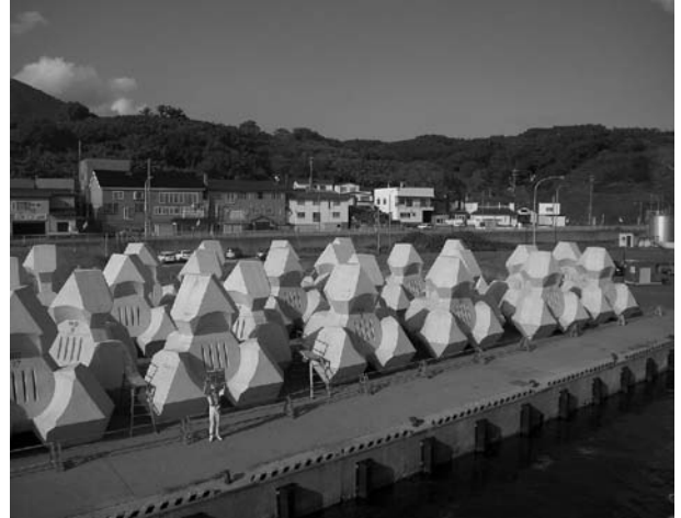
図-4 エプロン養生状況
