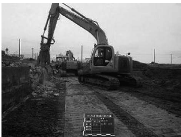
図-3 バックホウ油圧圧砕機解体状況
