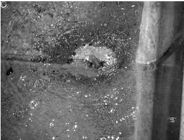
図-3 渠底部からの排水状況
