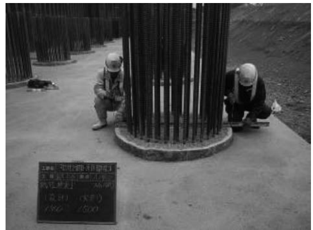
図-6 場所打ち杭完了
