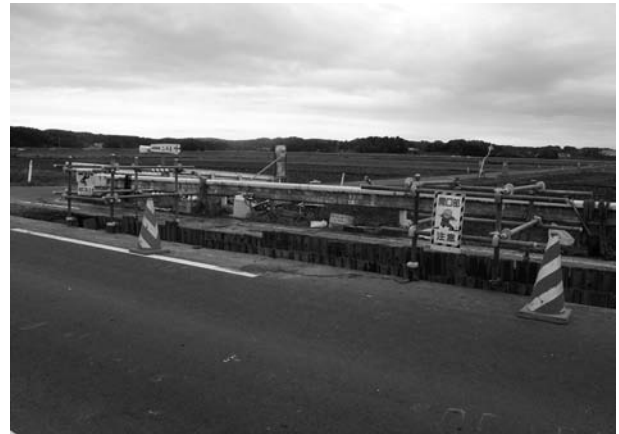
図-4 掘削継手箇所の転落防止柵 掘削した継手掘2箇所分の安全対策状況
