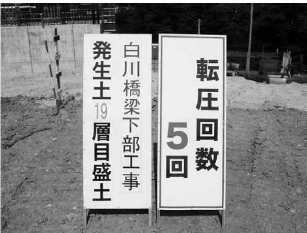
図-2 看板による工事名と転圧回数表示
