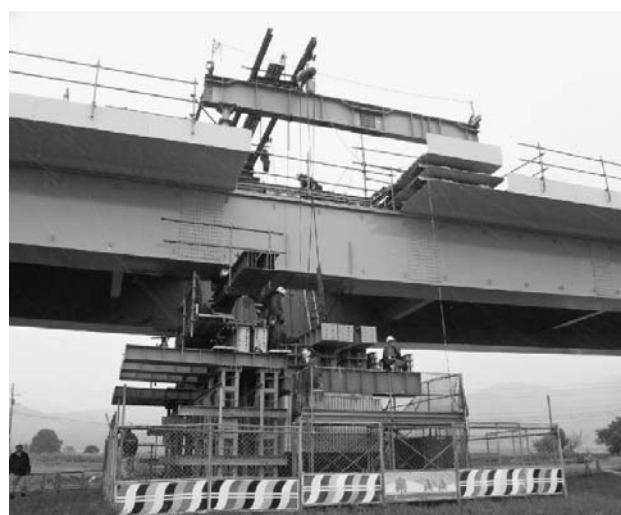
図-6 P1 送出し設備解体状況
