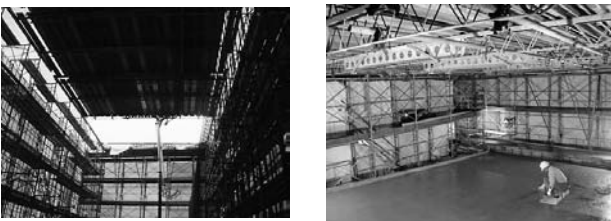
図-3 仮囲い内の作業状況
