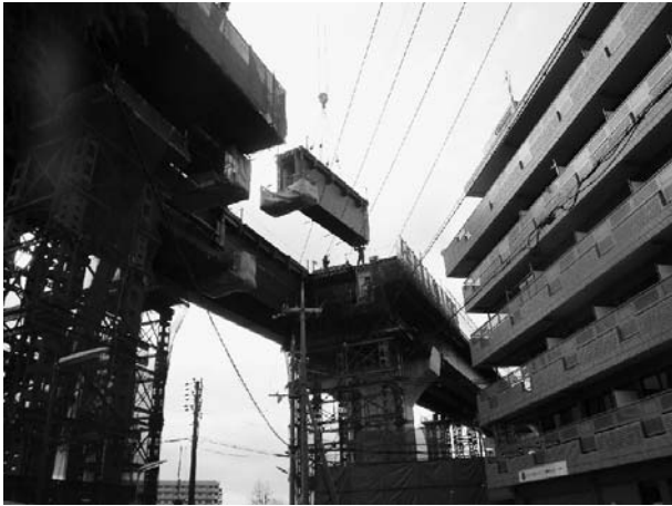
図-7 マンションなどが近接した箇所での施工状況
