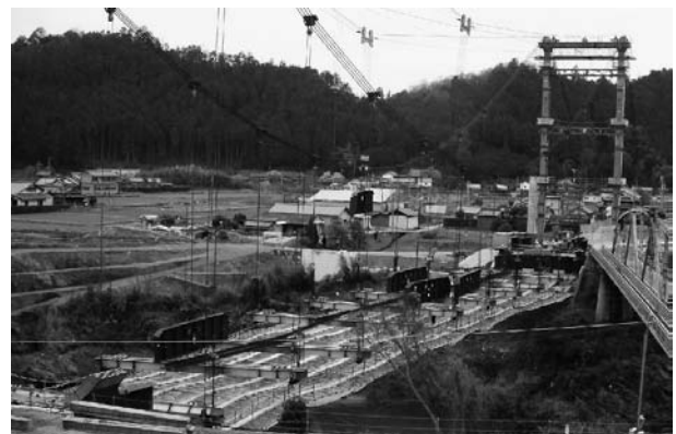
図-4 カウンターウェイト設置(横桁利用)
