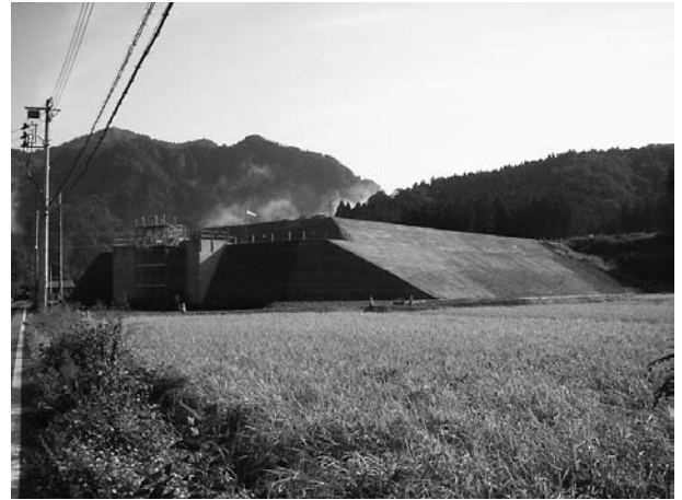
図-3 高路体盛土完了 (H=10m)
