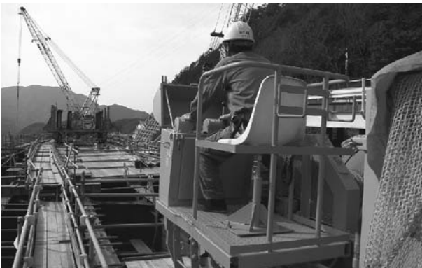
図-11 ウィンチによる逸走防止
