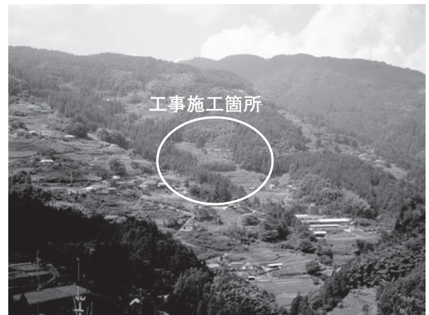
図-1 地すべり防止区域全景
