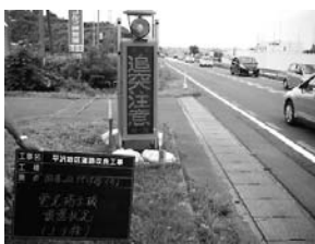
図-3 電光掲示板設置状況
