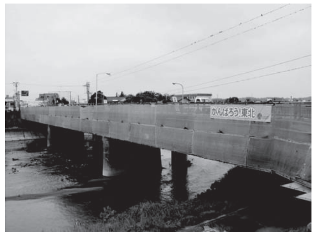
図-10 錦橋応急復旧工事全景
