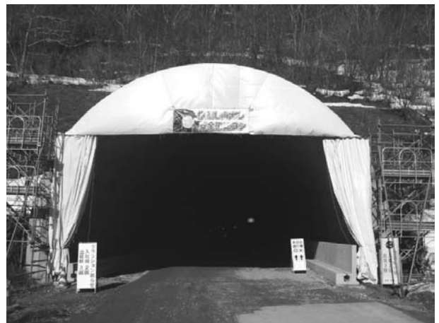
図-5 トンネル坑口の閉鎖 (開口時)
