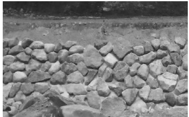
図-3 施工後半の巨石積工
