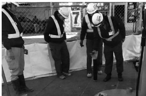
図-6 地中探査状況
