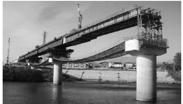
図-2 送出し架設状況
