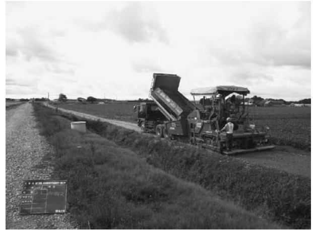
図-3 耕作道路 砂利敷均し状況
