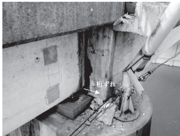
図-2 主桁の移動・断面欠損
