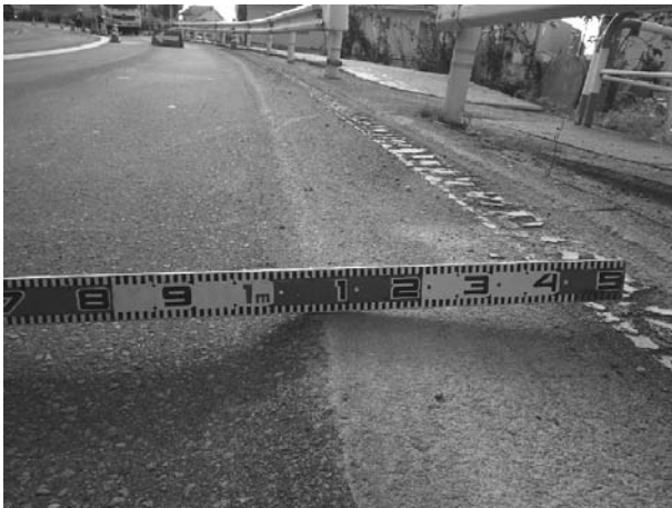
図-2 既設道路わだち掘れ状態
