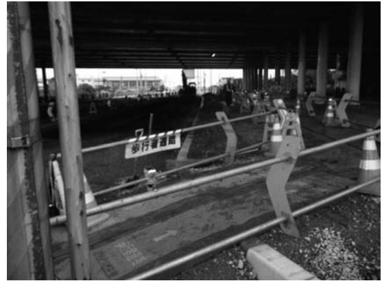
図-3 自発光カラーコーン・バリケード設置状況
