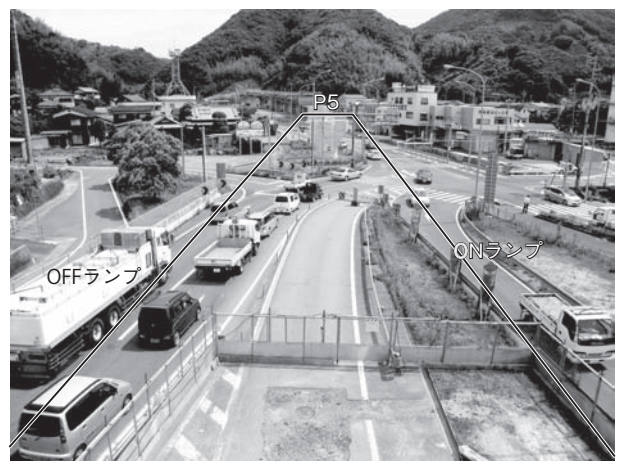
図-1 施工前現場状況写真 (P4上より撮影)
