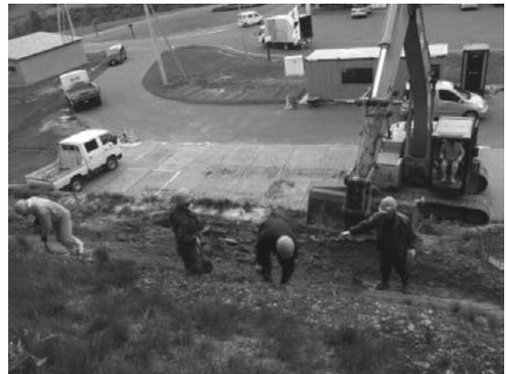
図-1 法面掘削作業
