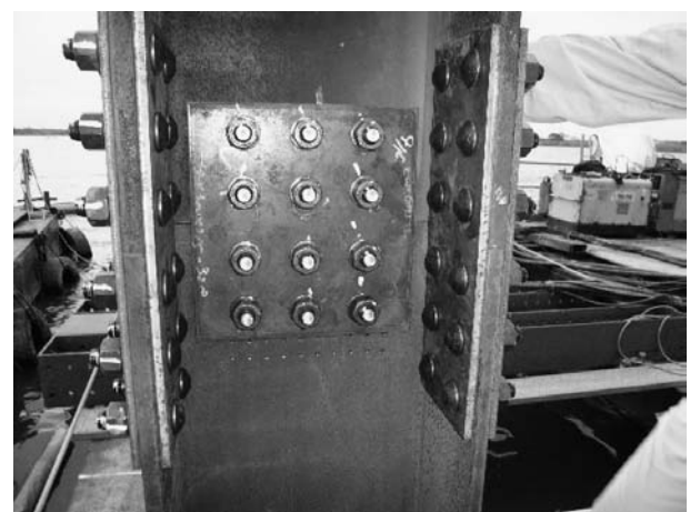
図-7 杭基礎の継手写真
