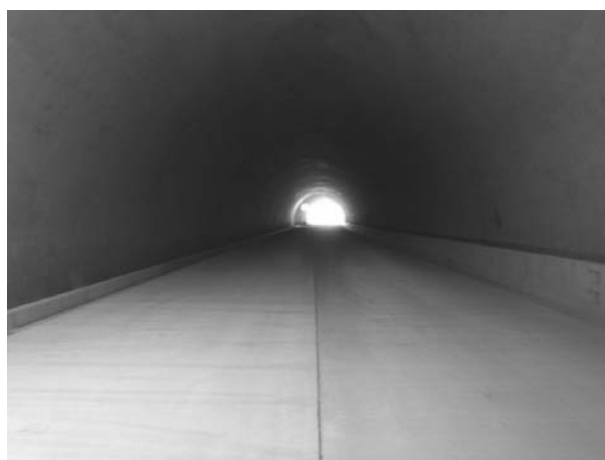
図-10 コンクリート舗装打設完了
