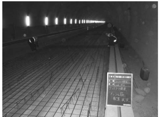
図-7 メッシュ筋設置状況
