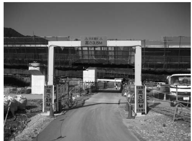
図-7 桁への衝突防止用高さ制限
