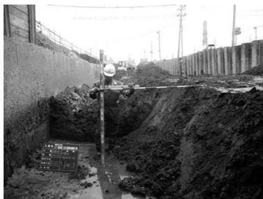
図-2 攪拌混合による付加土（残土）
