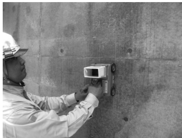
図-3 鉄筋探査状況(電磁波レーダ法)
