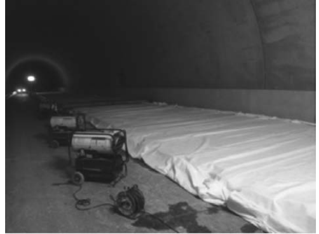
図-7 ジェットヒータによる吸熱・湿潤養生
