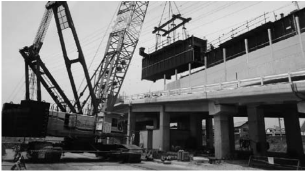
図-4 送だしヤード上への地組桁の架設
