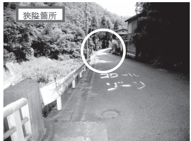
図-1 着手前県道状況
