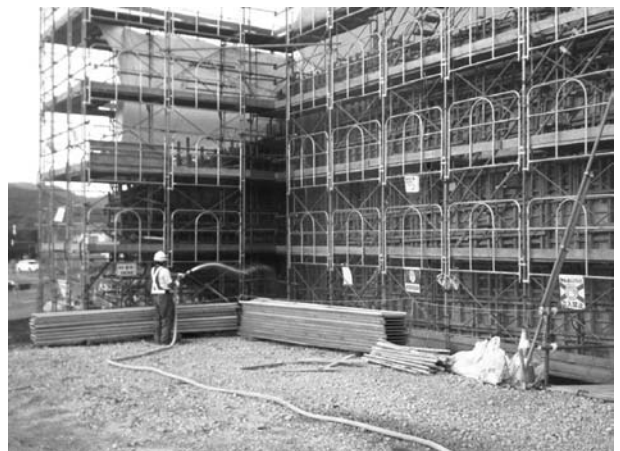
図-11 養生状況 (散水による温度低減対策)
