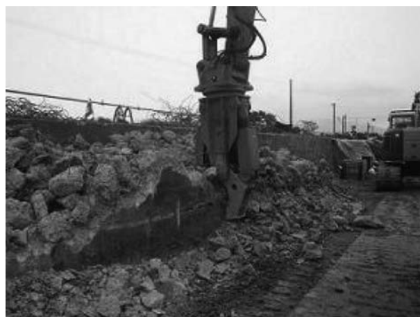
図-4 バックホウ油圧圧砕機解体状況
