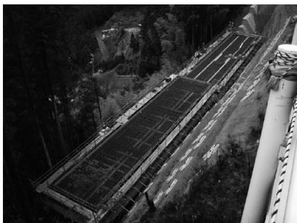
図-2 補強土壁基礎コンクリート打設前全景
