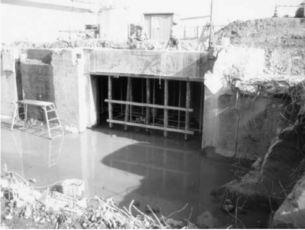
図-9 ワイヤソー切断前丸太補強
