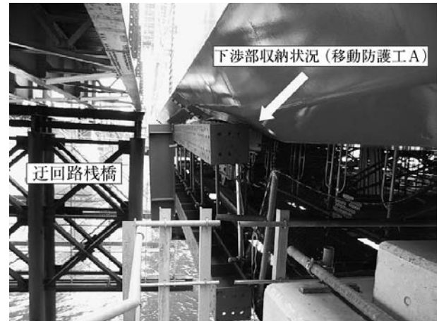
図-14 移動防護工A張出部収納状況
