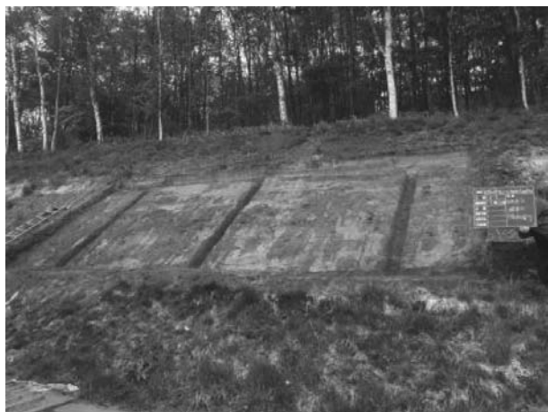
図-4 暗渠排水設置（掘削完了）
