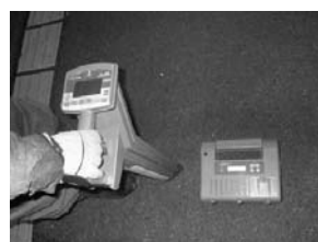
図-7 鋼管・ケーブル探知機
