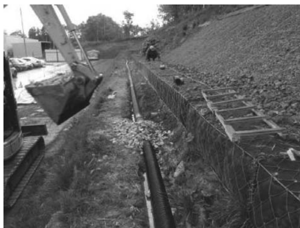
図-5 流末暗渠管設置
