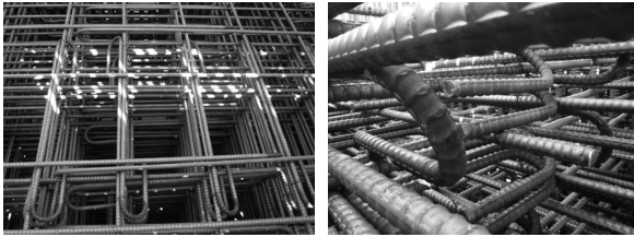
図-3 中間帯鉄筋の継手部
