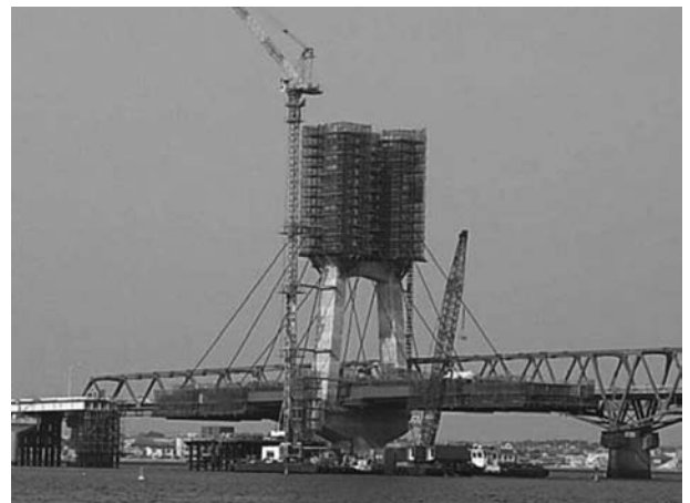
図-4 バランシング架設状況
