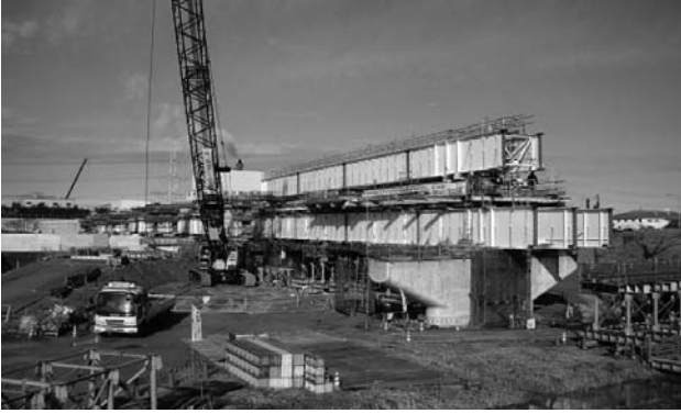
図-5 桁上ステージ上での桁組立
