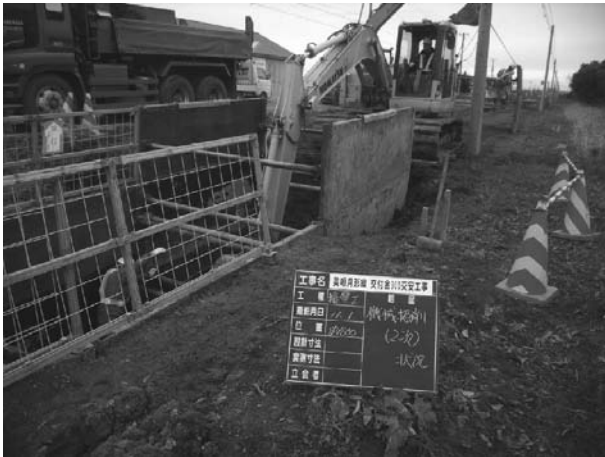
図-5 軽量パネル掘削状況
