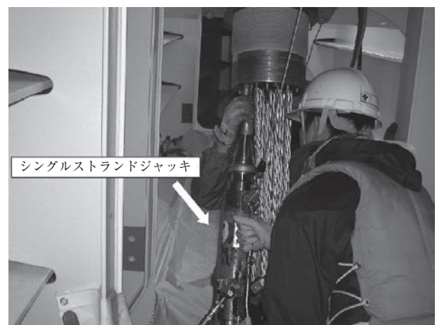
図-8 ケーブル緊張作業状況
