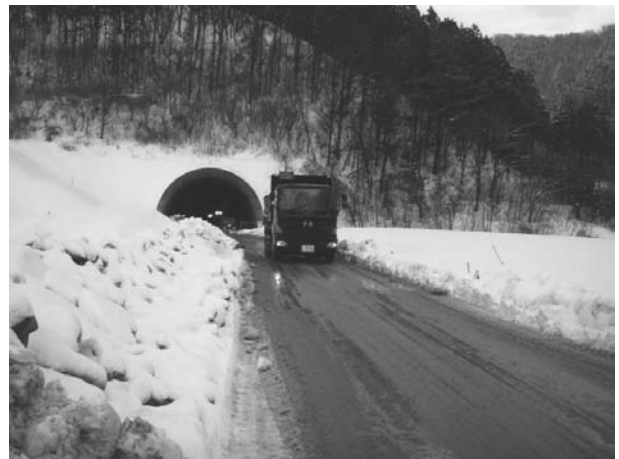
図-2 現場の周辺の積雪状況
