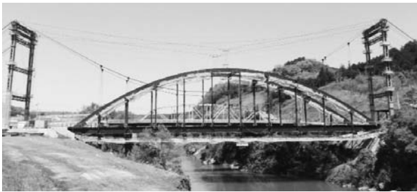
図-7 アーチリブ架設完了
