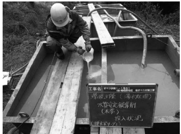
図-5 水質安定凝集剤の使用状況
