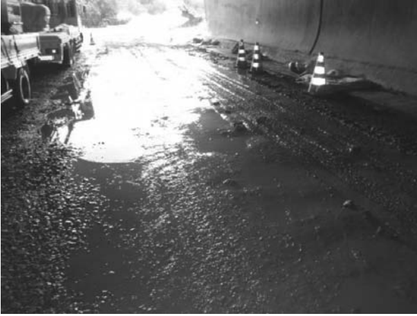
図-3 泥濘化したトンネル坑口付近の通行帯 (課題)
