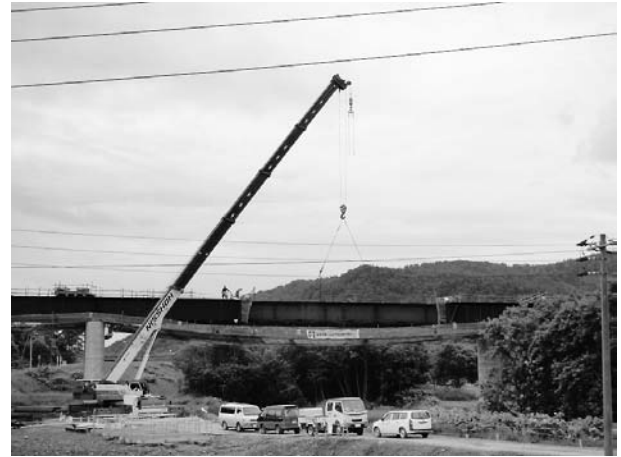
図-3 落とし込み架設状況
