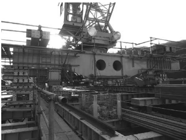
図-6 トラベラクレーン据付状況
