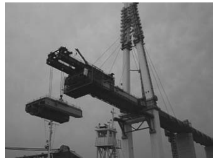
図-1 揚重機による架設状況
