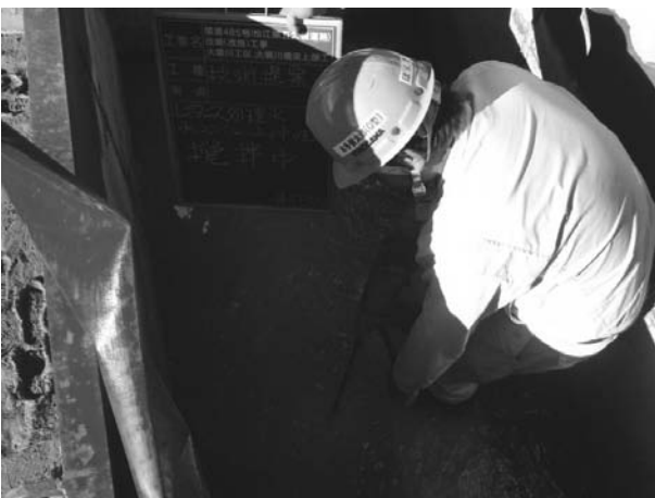
図-10 レイタンス処理水の浄化
