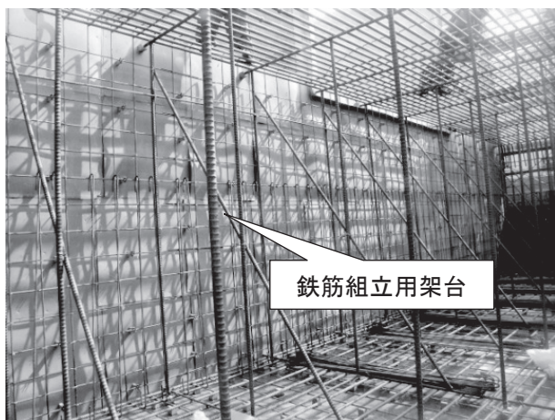
図-2 鉄筋組立用架台設置状況
