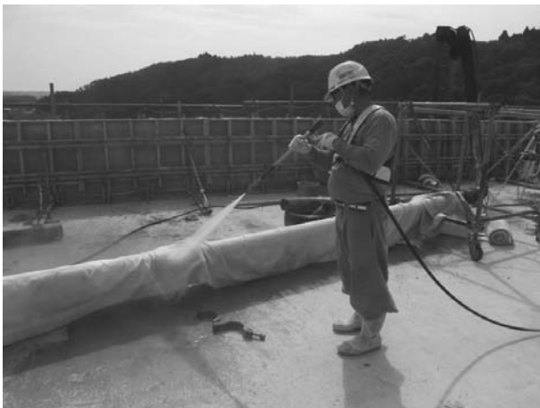
図-4 ポンプ配管の散水および養生
