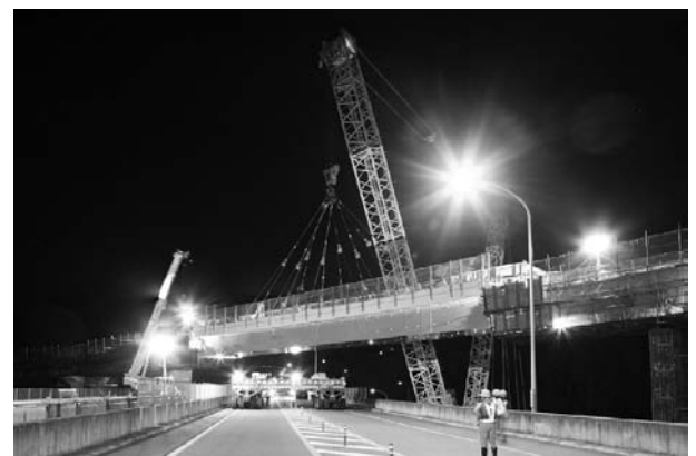
図-6 大ブロックの吊上げ状況
