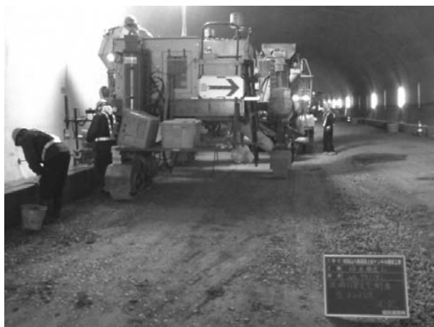
図-2 円形水路施工状況①
