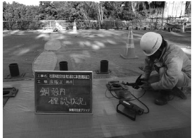
図-5 ファイバースコープによる確認状況
