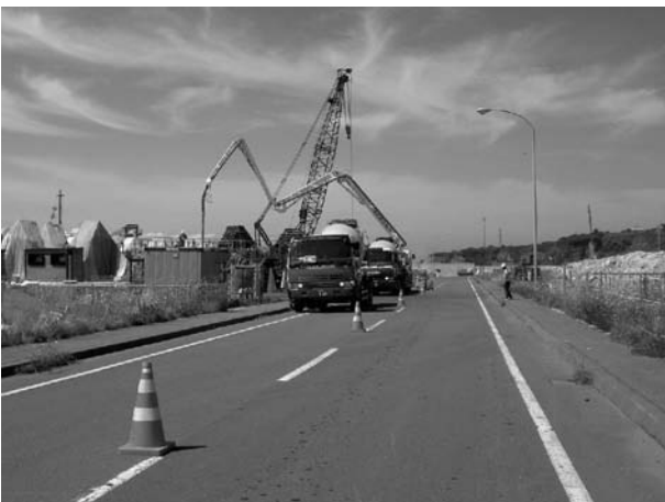
図-3 道路使用、誘導員配置状況
