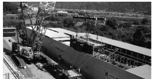
図-3 地組立作業専用の大型風防設備
