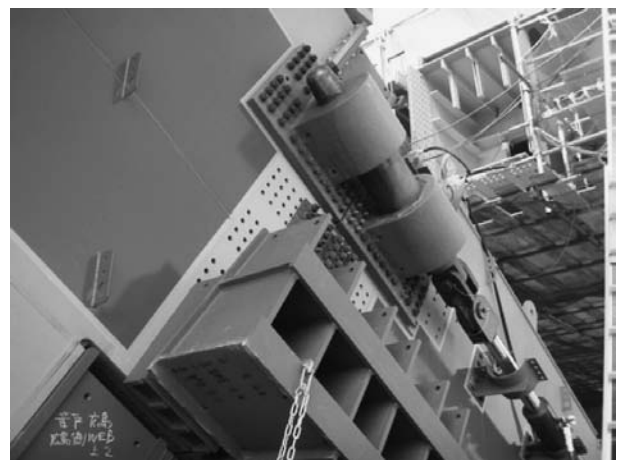
図-7 かんぬき・誘導ガイド(架設完了時)
