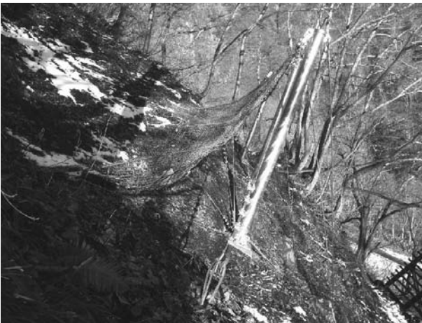
図-8 C工区 三角フェンス完成写真
