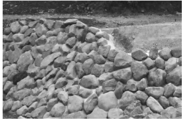
図-2 施工当初の巨石積工
