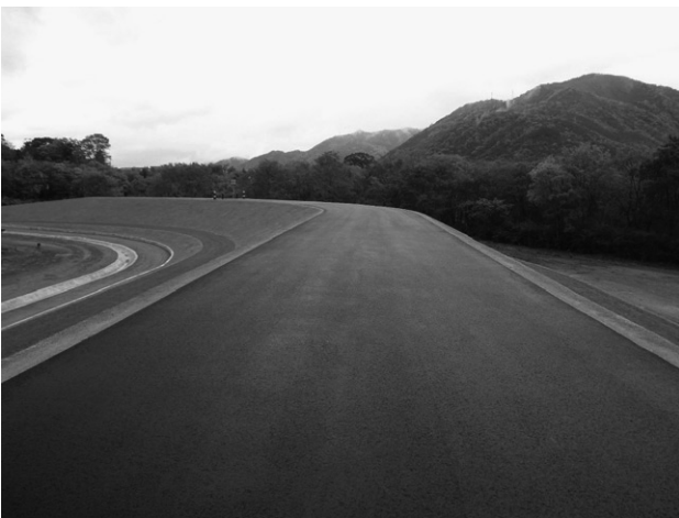
図-1 築堤盛土全景写真
