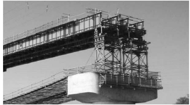
図-7 手延べ機先端につり下げたベント
