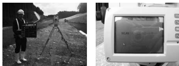
図-2 トータルステーションの使用状況
