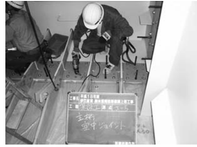
図-5 仮ボルト締付状況
