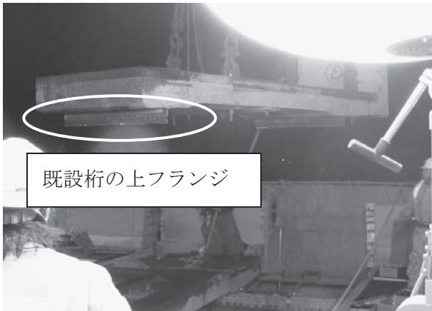
図-6 既設床版の撤去状況
