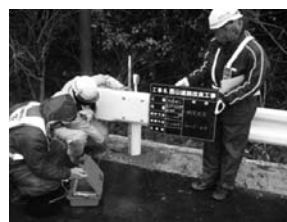
図-3 超音波測定器による測定・管理状況
