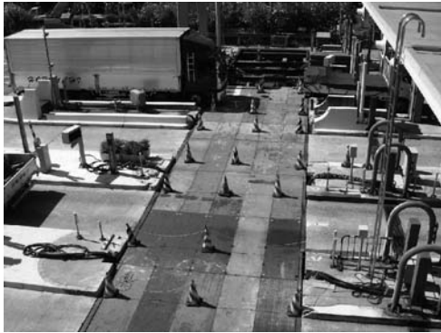
図-1 施工場所全景
