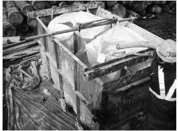
図-3 鋼製タンク及びトンパック
