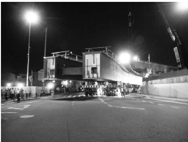
図-3 大型自走台車による運搬
