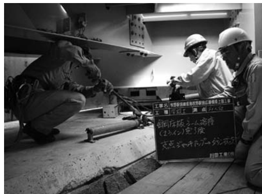
図-3 ジャッキアップ状況
