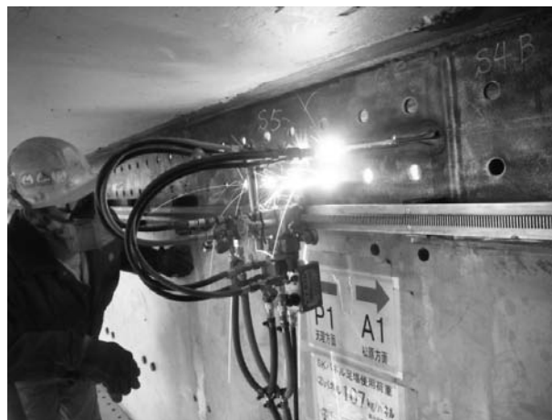
図－4 ガス切断状況
