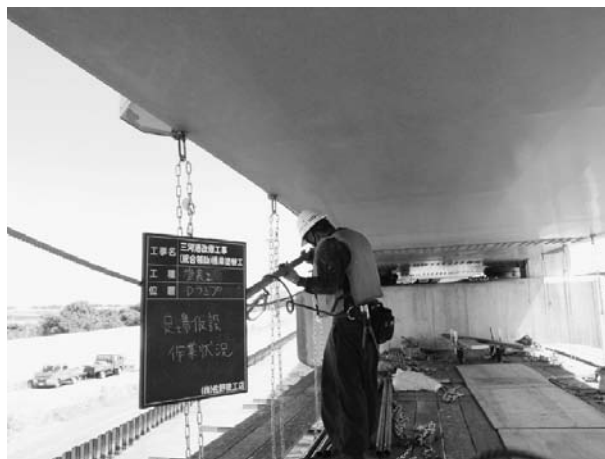
図-1 仮設作業時のライフジャケット着用
