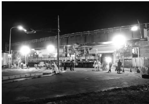
図-8 大型自走式キャリアによる架設
