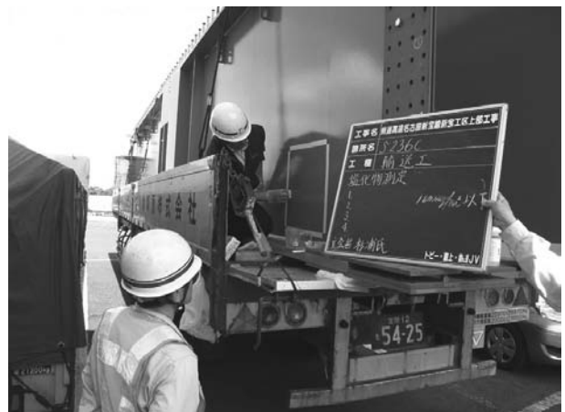
図-1 付着塩分量測定状況
