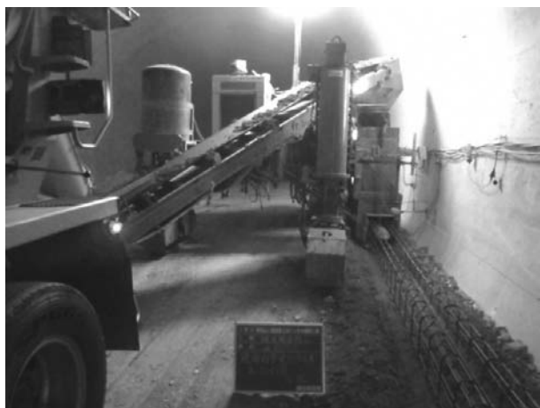
図-3 円形水路施工状況②
