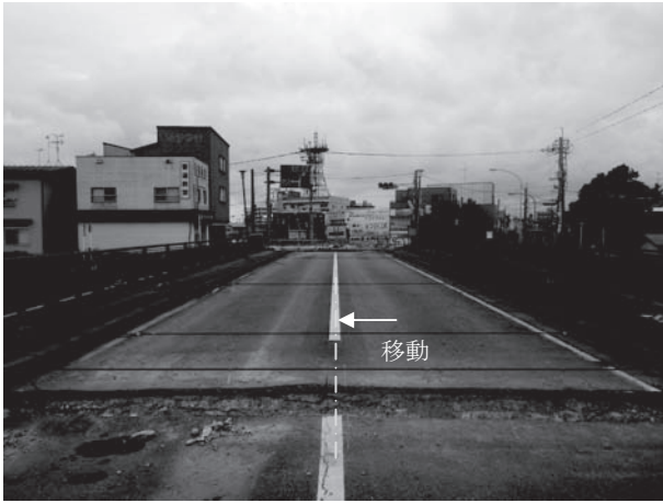
図-8 桁回転横移動完了
