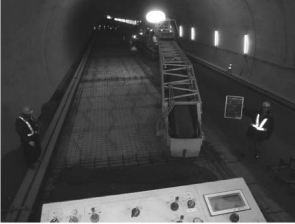
図-8 コンクリート打設状況（生コン供給）
