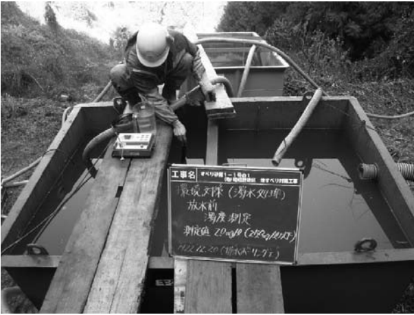
図-6 濁度測定状況
