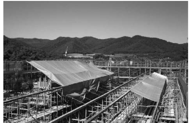
図-10 養生状況 (仮屋根による温度低減対策)
