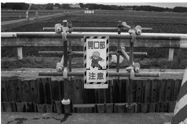
図-3 掘削継手箇所の転落防止柵 単管を組み、H鋼クランプで軽量鋼矢板に固定した状況
