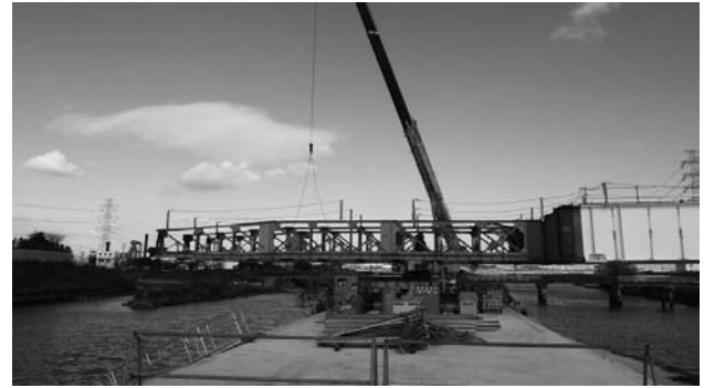
図-3 P4での手延べ機解体状況
