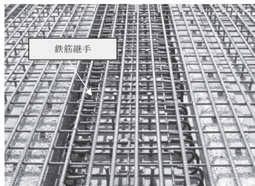
図-5 鉄筋継手
