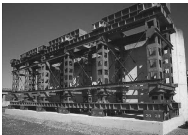
図-5 P1用ベント設備
