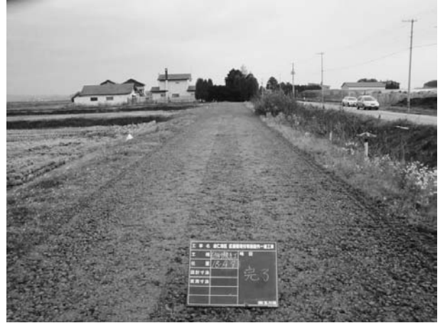
図-7 敷均し完成
