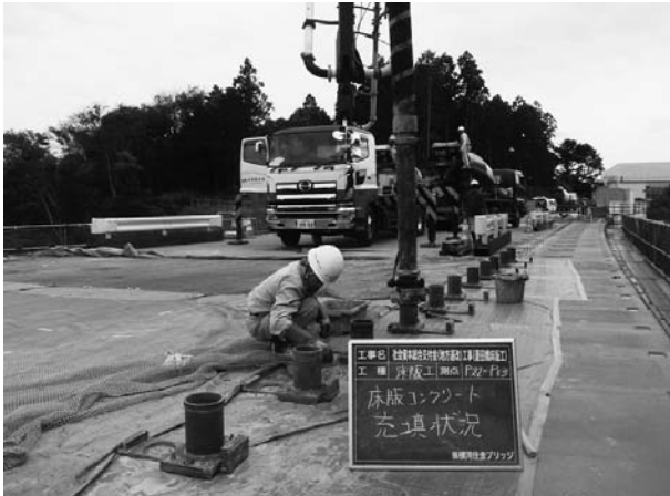
図-2 コンクリート充填状況（充填孔）
