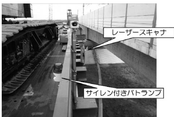
図-5 レーザースキャナー設置状況
