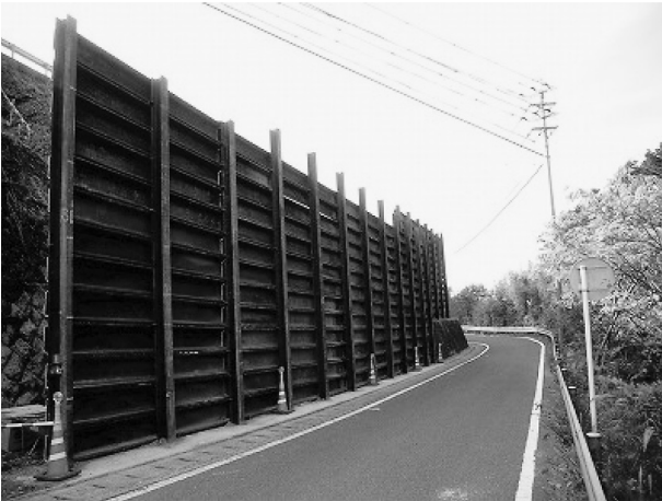
図-1 切取防護柵設置
