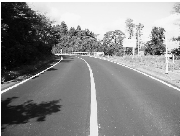
図-7 路面状況（施工後）
