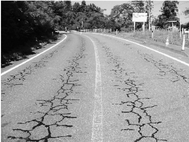
図-6 路面状況（施工前）
