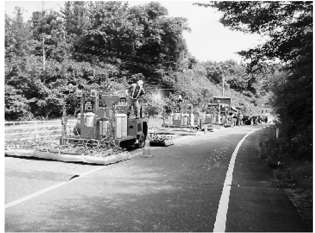
図-3 路面加熱状況
