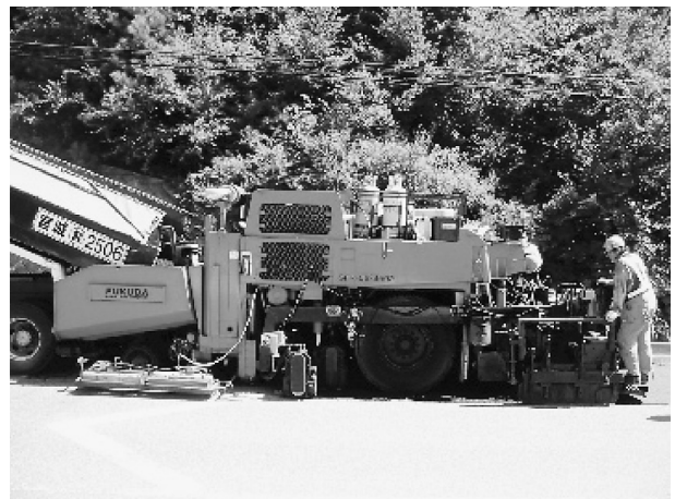
図-4 路上表層再生機による施工状況
