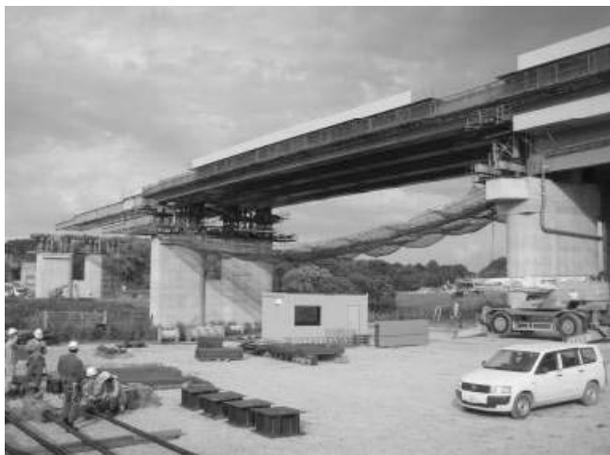
図-7 送出し架設状況（先行吊り足場）
