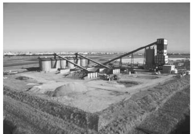
図-2 仮設プラント全景
