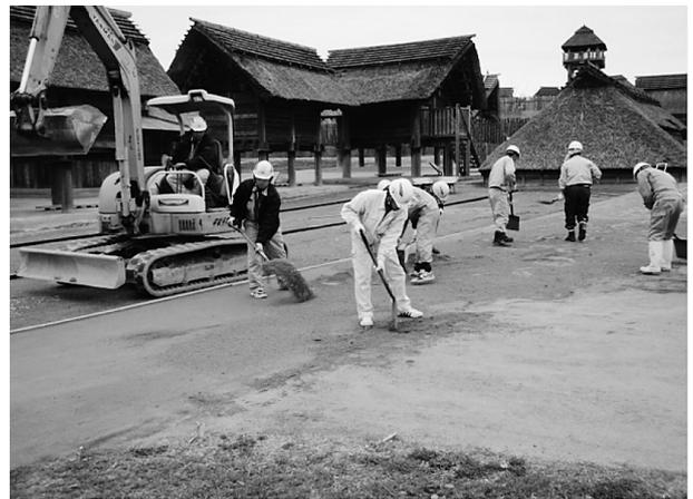
図-8 仕上げ転圧前のマサ土散布
