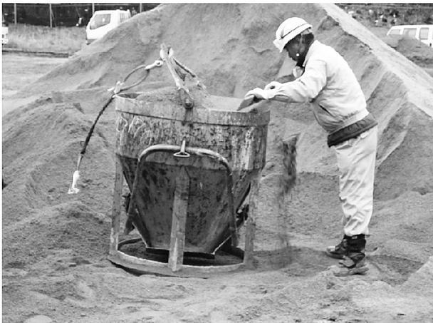
図-3 コンクリートホッパーによるマサ土の計量
