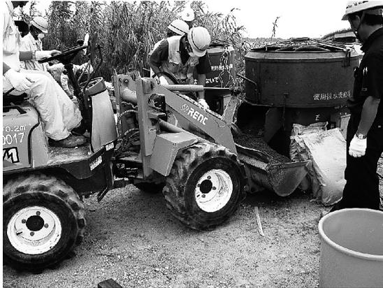
図-2 通常の土系混合物製造方法
