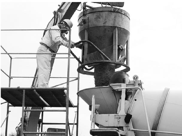
図-4 アジテータへの材料投入
