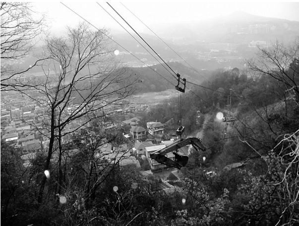
図-1 着工前現場付近
