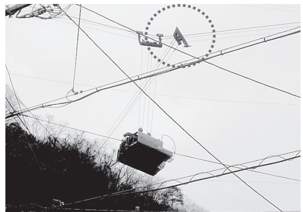
図-5 空中折曲げ装置付ケーブルクレーン
