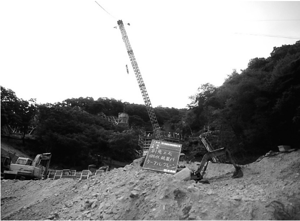
図-8 起伏装置付きケーブルクレーン
