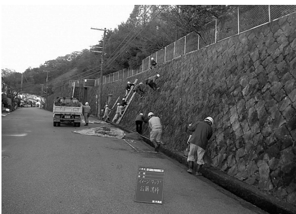
図-9 現場付近清掃
