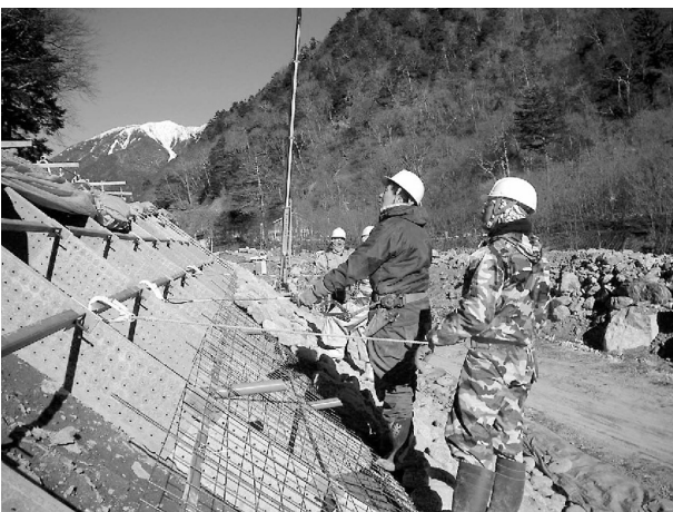
図-7 作業中の安全帯使用状況
