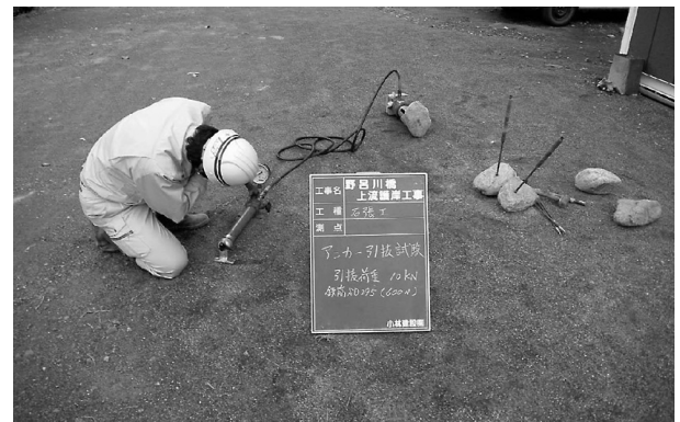
図-5 アンカー引抜試験確認状況
