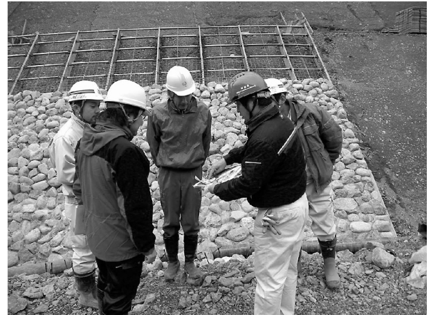
図-4 発注者と現場での確認状況
