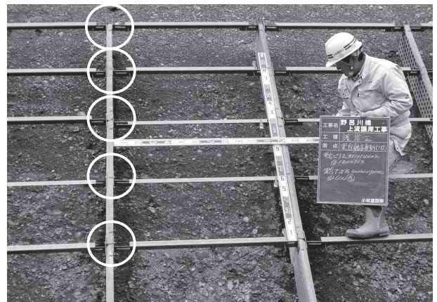
図-9 改善後～スライド式の型枠組立状況
