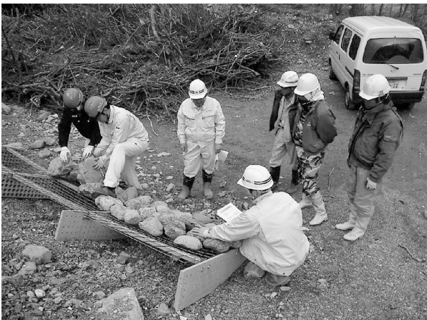
図-3 試験施工ヤードによる確認状況
