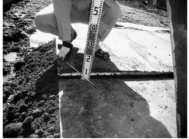
図-9 試験時の沈下状況写真
