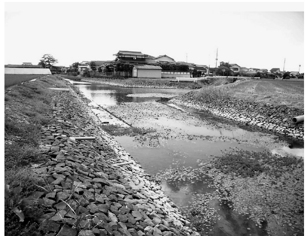
図-11 竣工 2 年後の B 路線の写真
