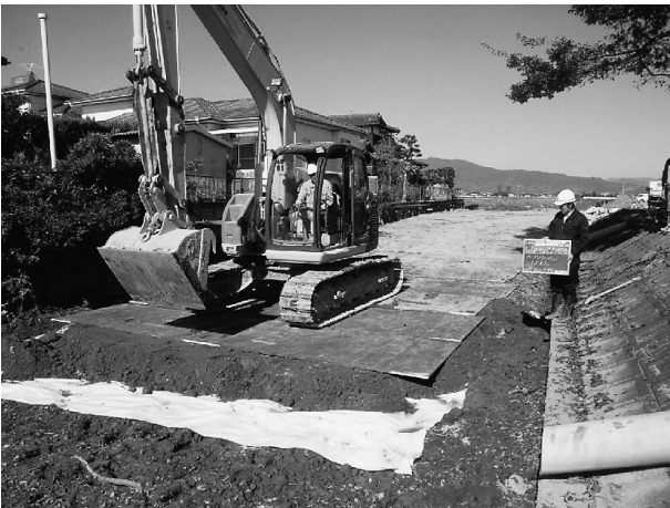
図-8 試験施工状況写真
