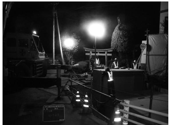
図-3 防火水槽設置状況
