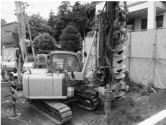
図-2 マルス工法先行掘削状況
