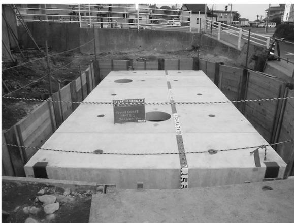
図-4 防火水槽設置完了
