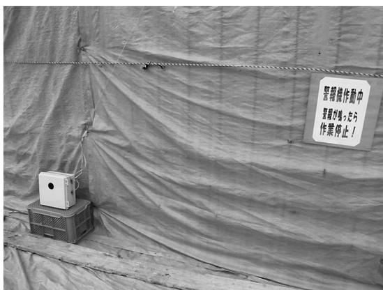
図-9 ワイヤーセンサー設置状況
