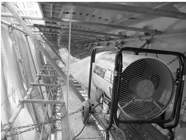
図-5 張出部ジェットヒーター配置
