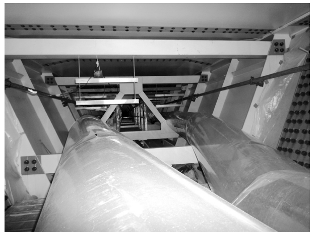
図-6 箱桁内ポリダクト配置
