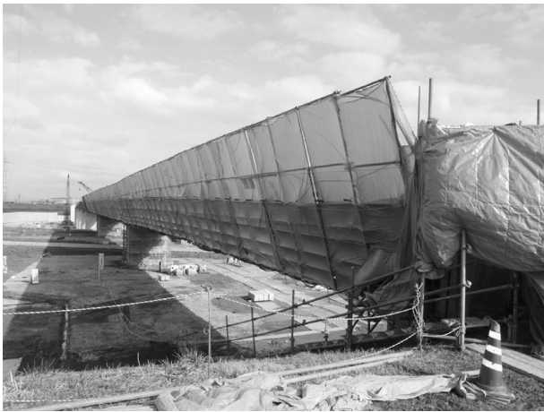
図-4 朝顔足場シート養生
