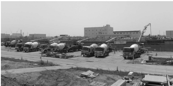
図-1 生コン打設状況（コンクリートポンプ車5台）
