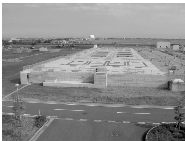
図-5 完成写真全景
