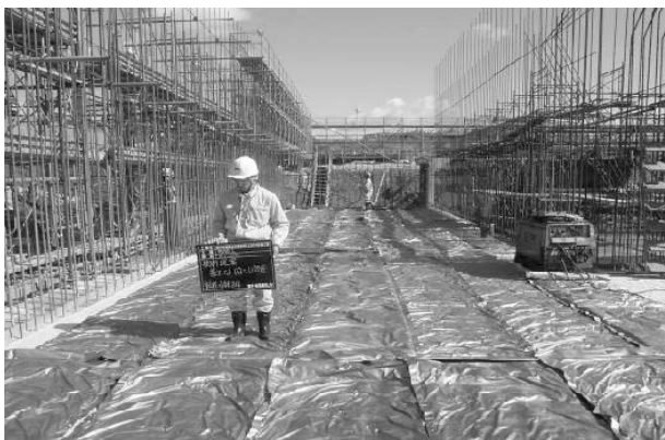
図-3 Q マット敷設状況
