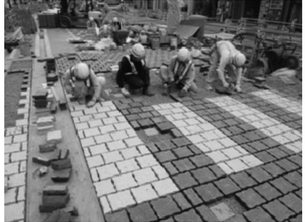
図-7 自然石ブロックの据付け (横断舗装部)
