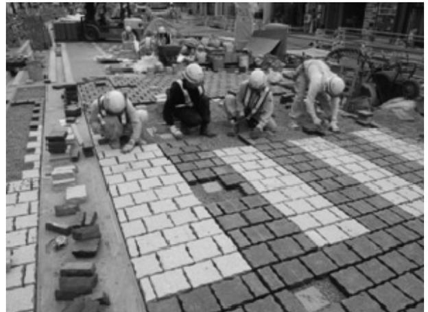
図-8 ベースファルト充填状況
