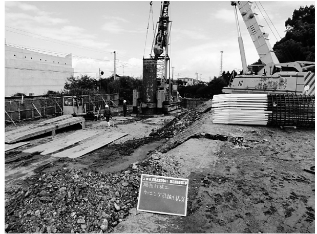
図-4 ケーシング引抜状況
