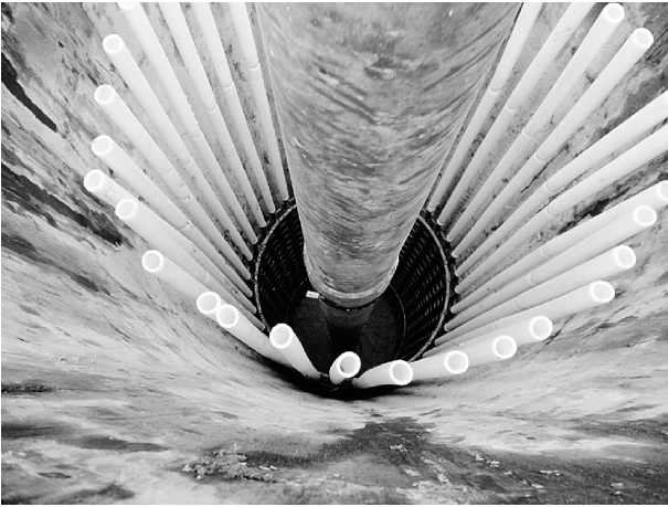
図-6 コンクリート打設状況
