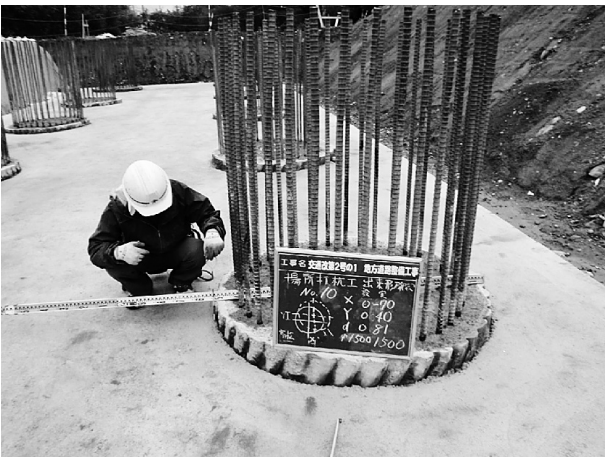
図-2 余盛コンクリート撤去完了
