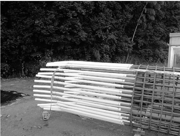
図-3 発泡スチロールカバー設置状況
