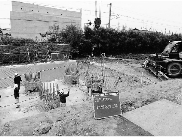
図-1 余盛コンクリート撤去状況
