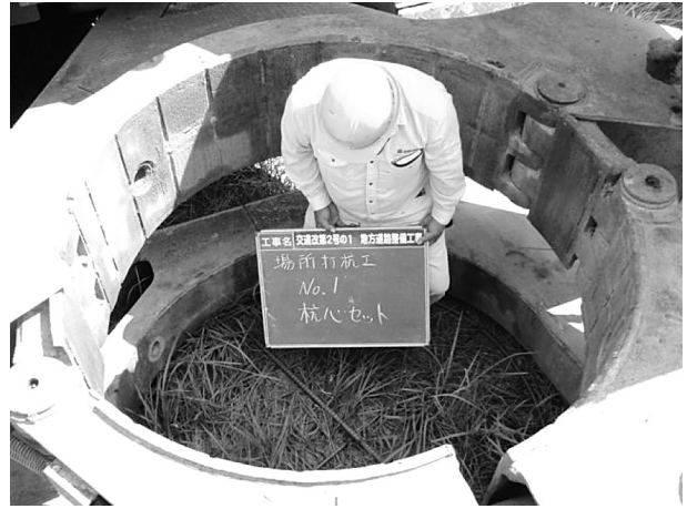
図-7 杭芯セット
