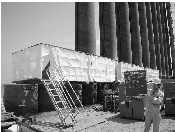
図-5 実際の取付・使用状況
