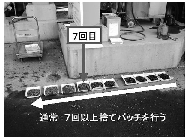
図-5 捨てバッチによる混合物の色の変化
