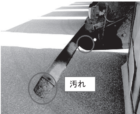
図-7 バンパーフレームの汚れ
