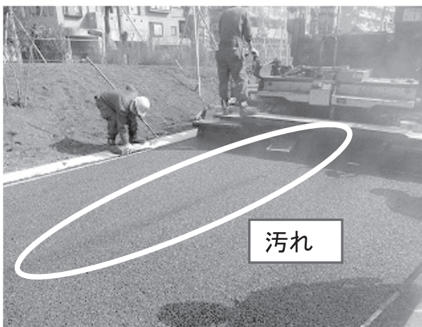
図-3 敷均し面センターの汚れ
