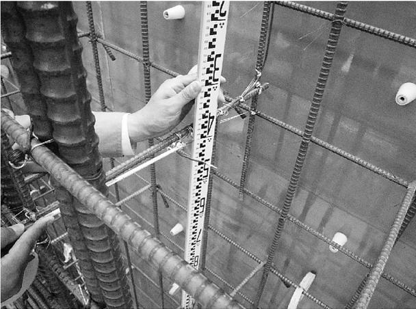
図-5 熱電対(側壁部)
