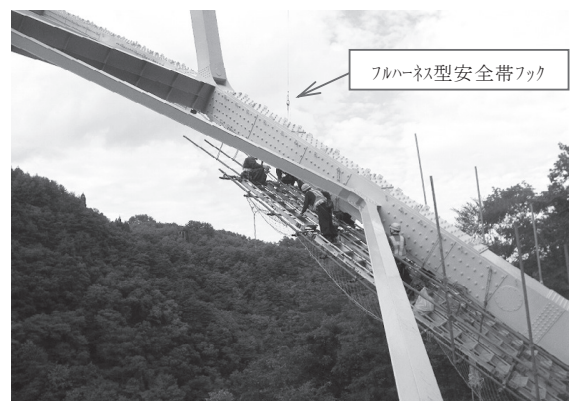
図-6 足場解体状況
