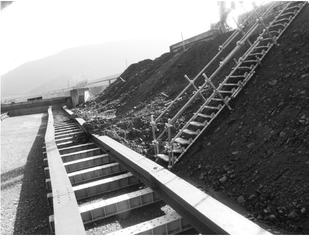
図-5 送出シャードの法面崩壊（軌条設備の蛇行）
