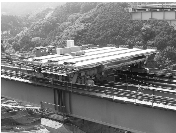
図-10 PC 床版搬送台車
