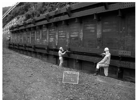
図-4 親杭土留めアンカー工 完了
