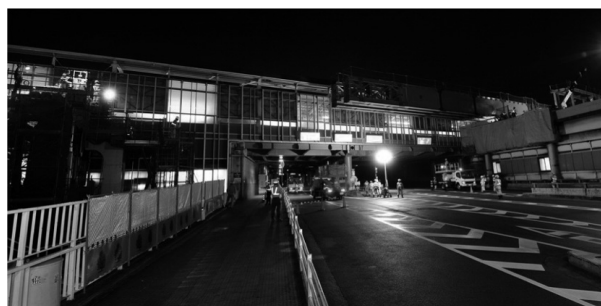
図-11 送出し架設状況(国道423号通行止規制)
