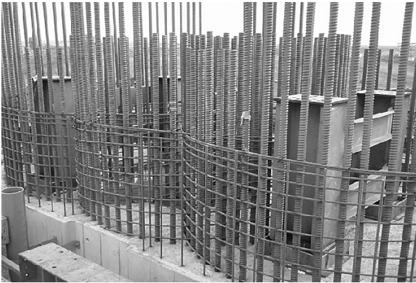
図-5 鋼桁仮受け架台
