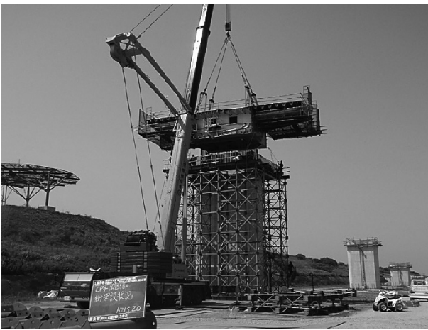
図-6 剛結部鋼桁架設状況
