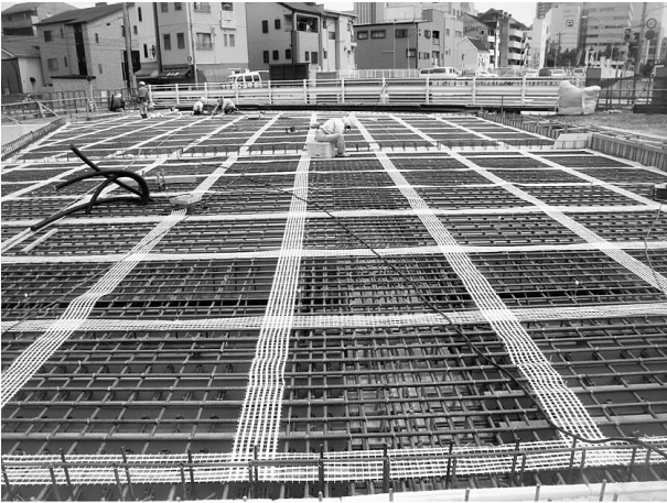
図-6 ひび割れ抑制ネット敷設状況
