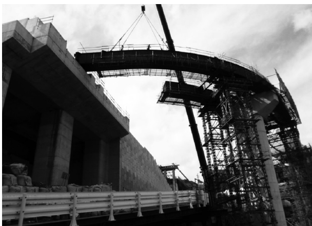
図-6 R30m 部分架設（A1～P1）
