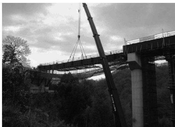
図-8 斜ベント併用架設（A2近傍）
