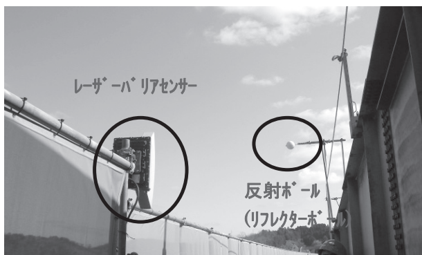
図-4 レーザーバリアセンサー
