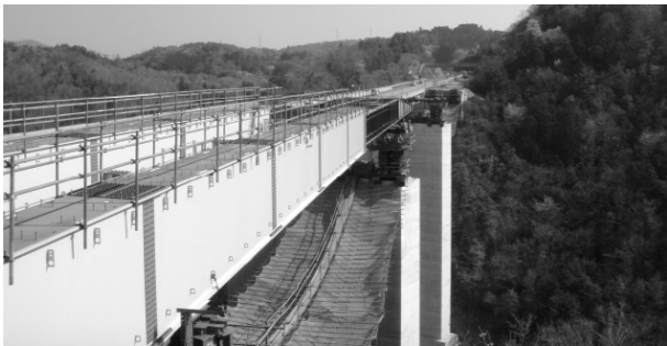
図-2 送り出し架設状況
