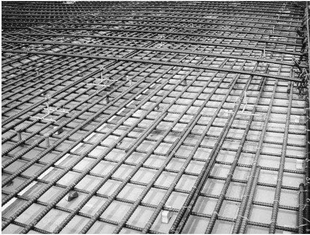
図-6 床版配筋状況（下側組立鉄筋使用なし）
