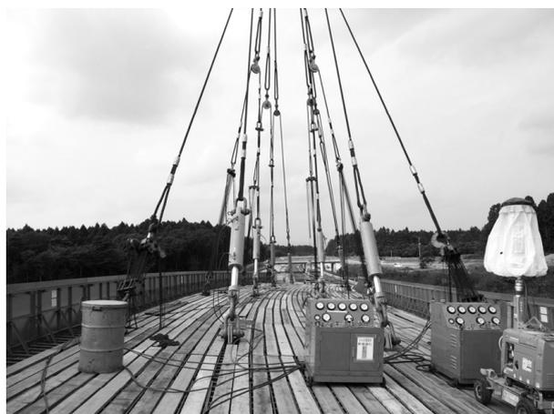
図-5 吊り上げ装置
