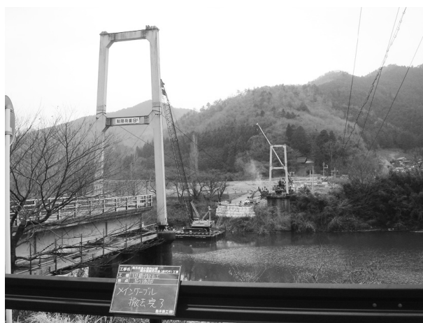
図-8 メインケーブル撤去完了(右岸より)
