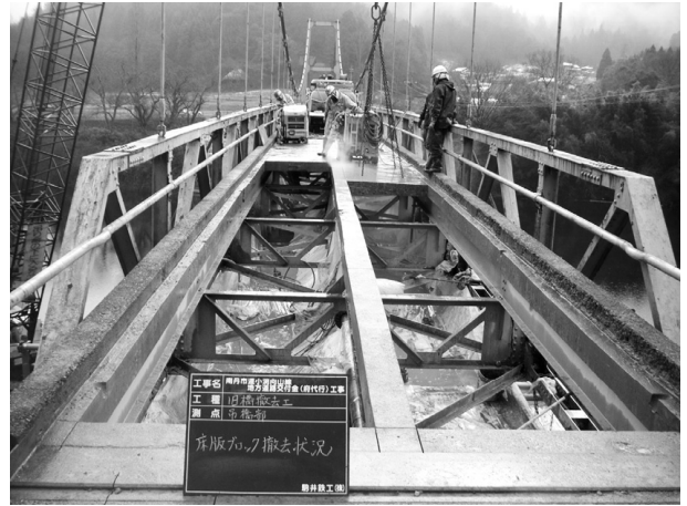
図-4 床版ブロック撤去状況
