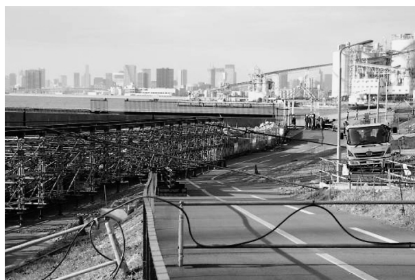
図-6 ワイヤー防護設備
