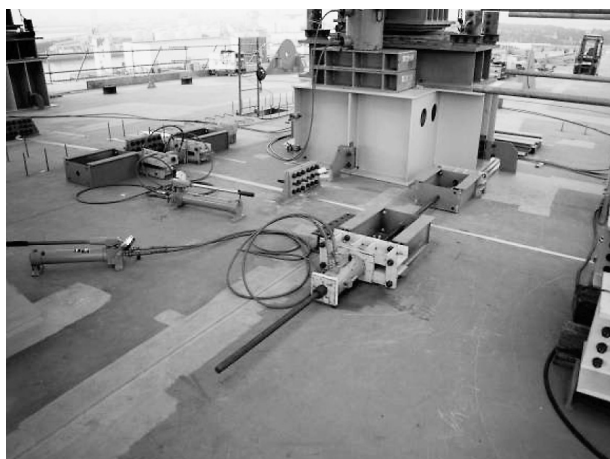
図-5 支口調整設備（DECK上）
