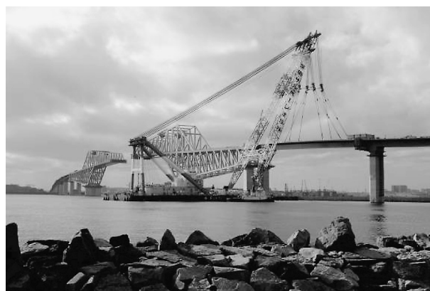
図-7 工区最終ブロック架設状況
