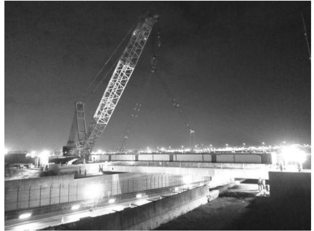
図-10 桁架設状況
