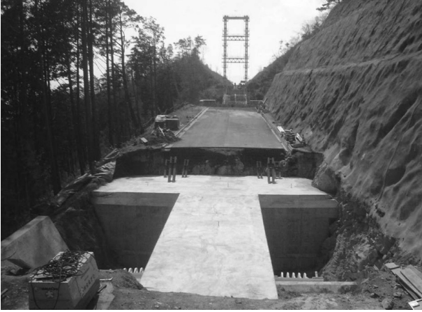
図-5 アンカー設備の分割施工
