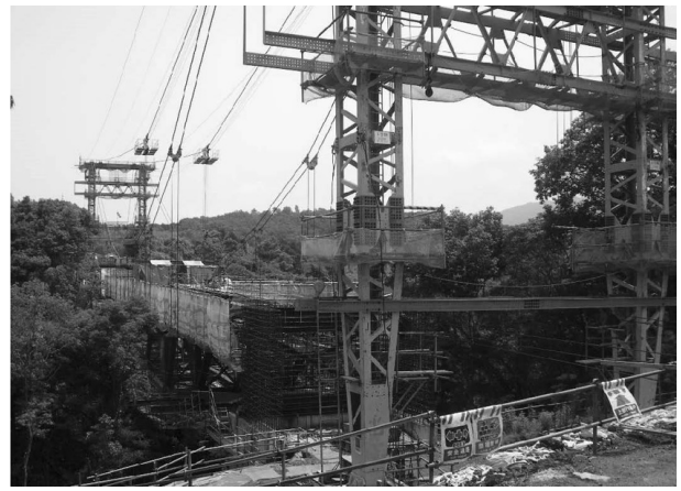
図-11 架設状況写真
