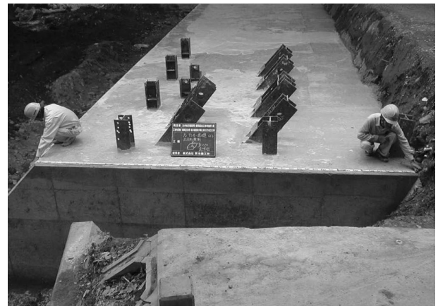
図-4 堤防と一体化したコンクリートブロック
