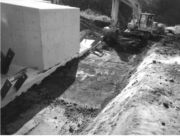
図-8 A2側アンカーブロック前面埋戻し
