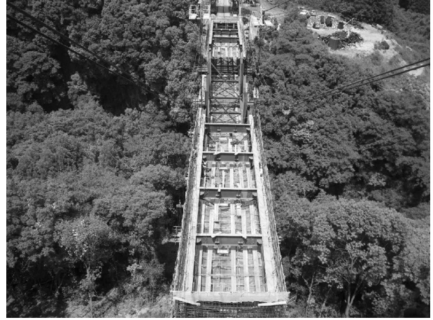
図-10 架設状況写真
