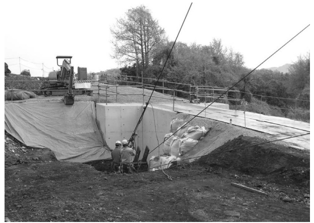
図-7 アンカーブロック完成側面
