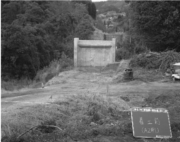
図-2 A2側アンカーブロック着工前
