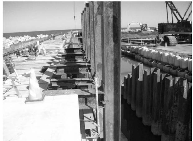
図-9 鋼材による固定状況
