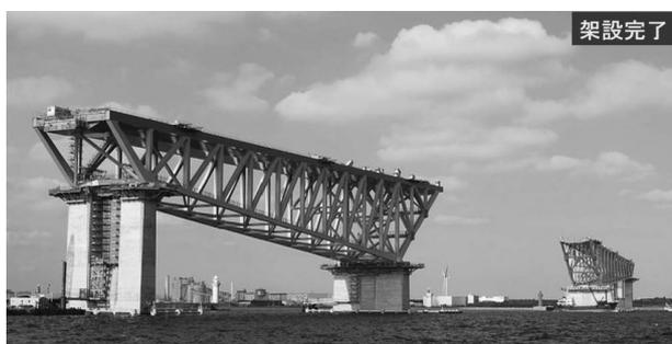
図-12 側径間トラス架設完了
