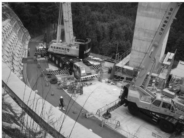
図-7 規制状況（通行帯確保）
