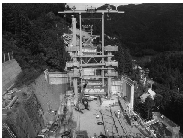
図-8 鉄塔設備組立状況
