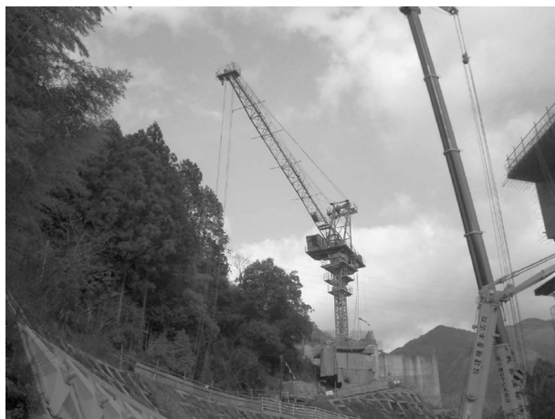
図-5 タワークレーン（JCC-120）
