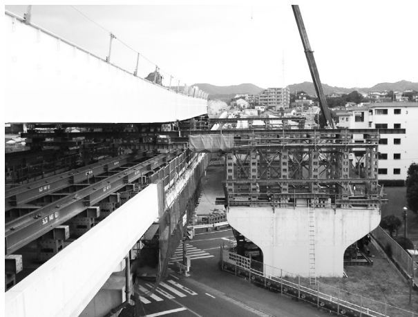
図-3 横取り設備
