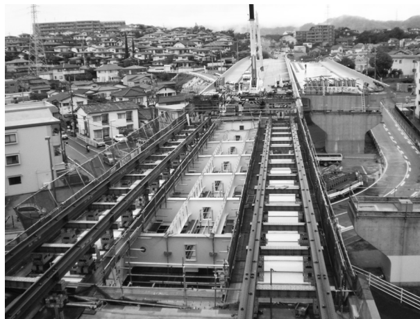
図-2 縦取り軌条設備
