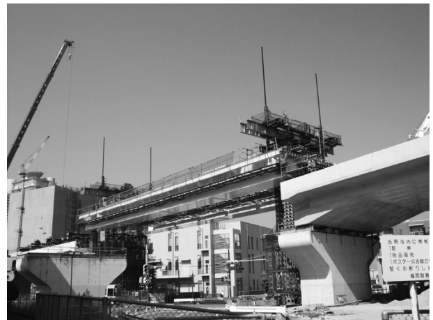
図-5 降下設備(全景)
