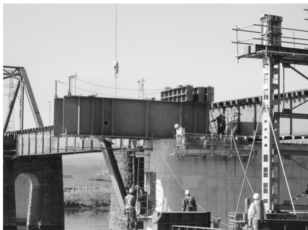
図-5 P2仮受けブラケット配置状況
