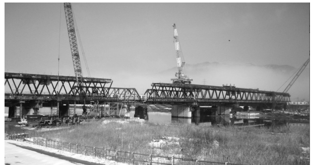
図-4 新トラス桁架設状況（奥が旧橋）
