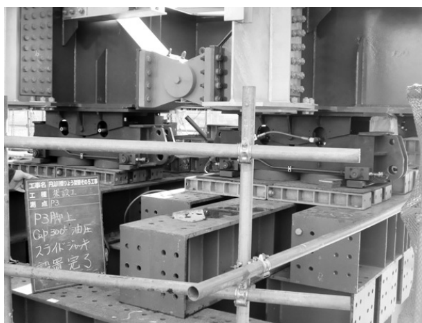
図-6 P3スライドジャッキ配置状況
