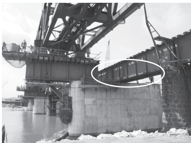
図-8 旧桁撤去後、○位置に仮受け架台を設置する
