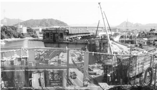
図-10 旋回横取り施工完了
