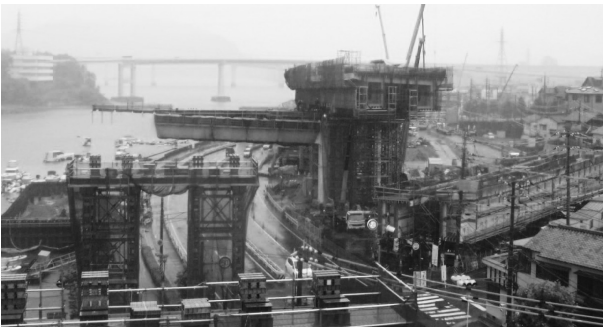
図-9 旋回横取り施工前
