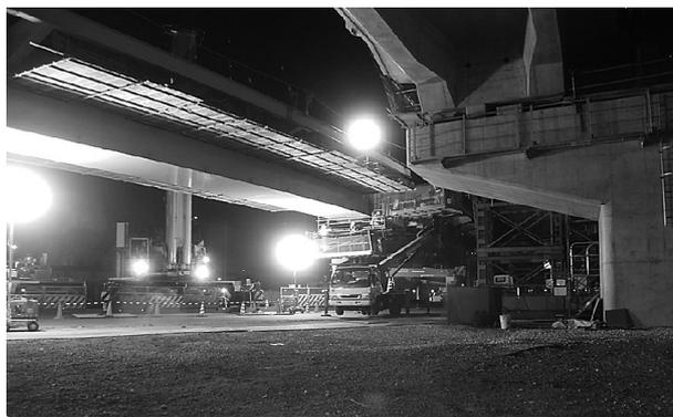
図-5 360t桁架設状況
