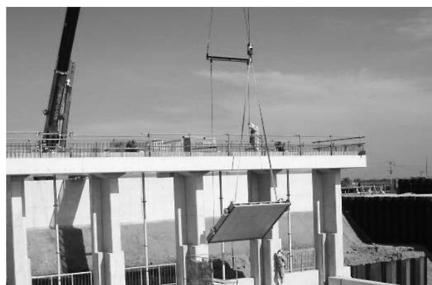
図-3 クレーンの親子フックを用いた吊込方法
