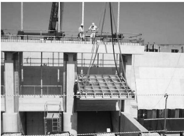
図-5 開閉装置を用いた吊込方法
