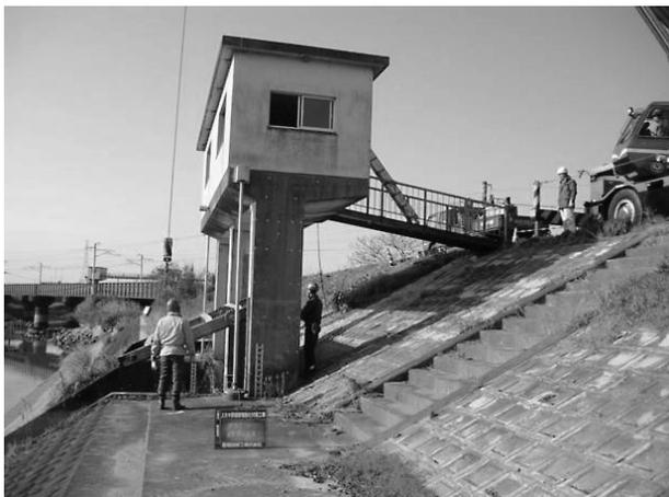
図-7 チェーンブロックを用いた吊込方法
