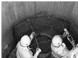
図-12 埋込坑口掘削状況
