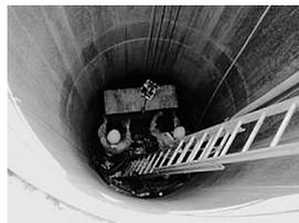
図-13 埋込坑口取付
