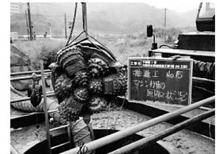
図-14 マシン分割回収状況 図-15 マシン分割回収状況
