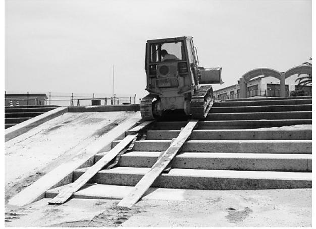
図-6 重機搬入・出時の養生状況
