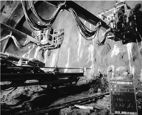
図-5 注入式短尺鏡ボルト施工状況
