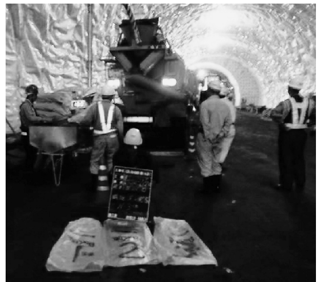
図-6 覆工コンクリート繊維添加状況
