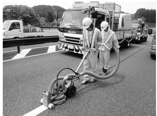
図-1 区画線消去状況
