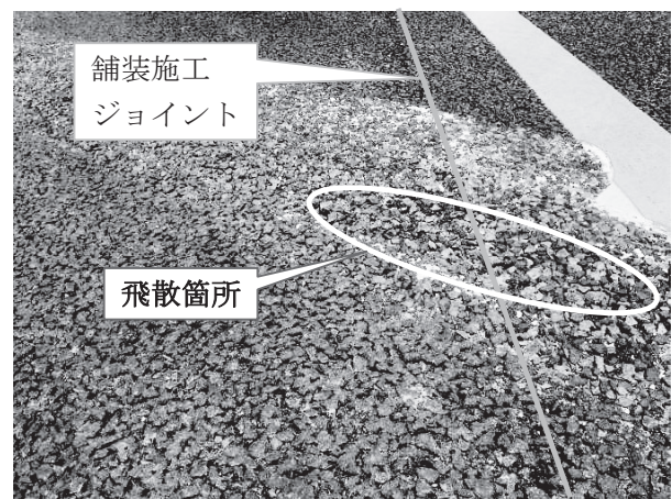
図-2 骨材飛散発生部
