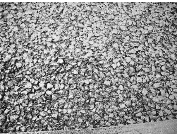
図-5 トップコート完了（接写）
