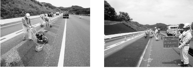
図-3 補修・トップコート状況
