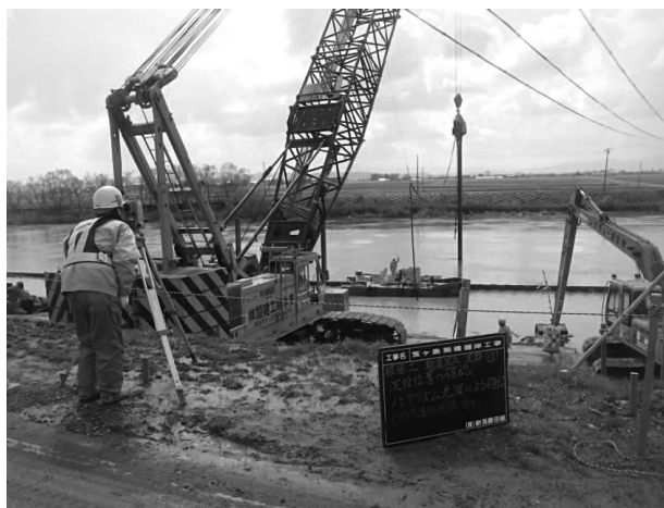
図-3 沈設ガイド鋼材の設置位置出し測量
