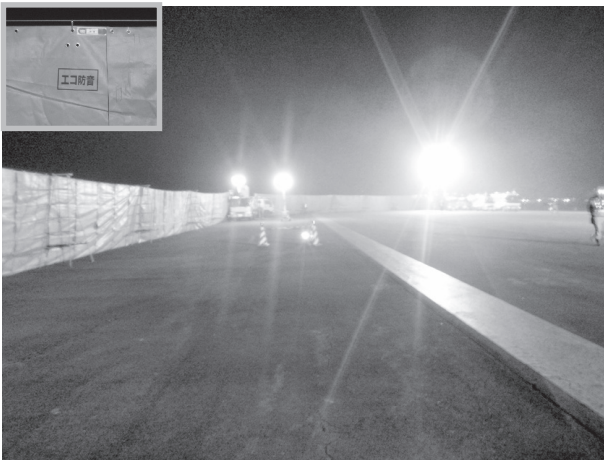
図-2 施工区間防音シート設置状況
