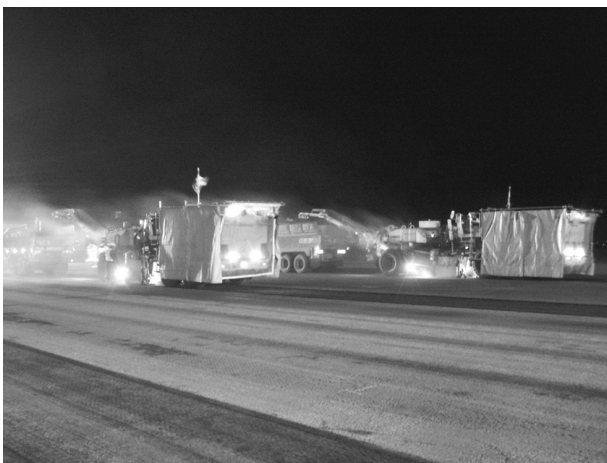
図-3 切削機防音シート設置状況
