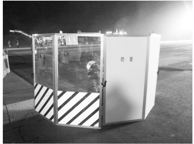
図-4 電動ピック使用時の防音パネル設置状況
