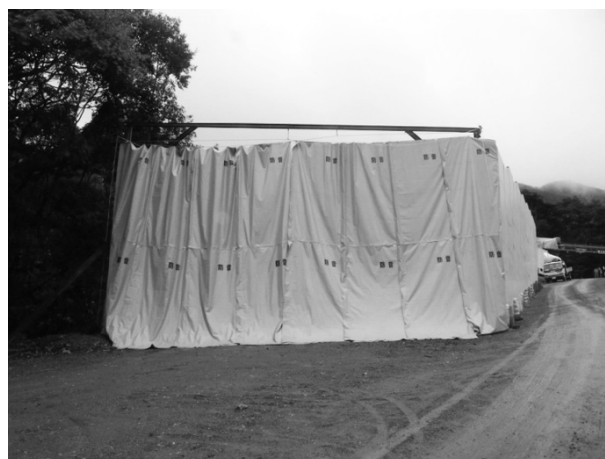
図-5 ずり仮置き場前の防音シート設置状況
