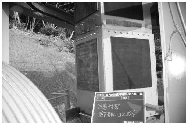
図-3 乗継部カバーのゴム板取付け状況
