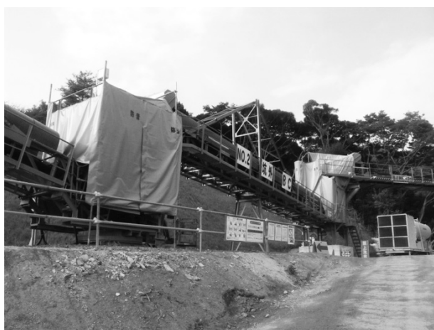
図-4 乗継部の防音シート設置状況
