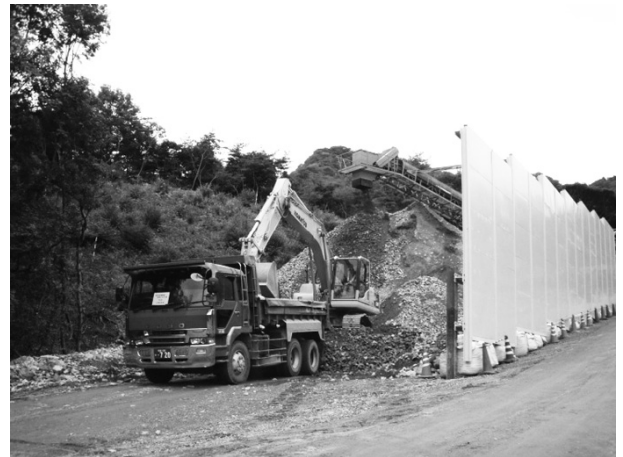
図-2 ずり仮置き場付近、防音壁設置状況
