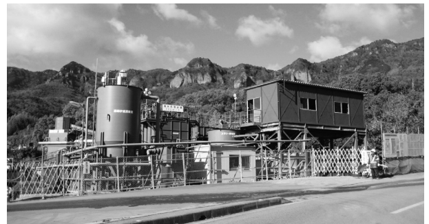
図-2 濁水処理設備全景写真
