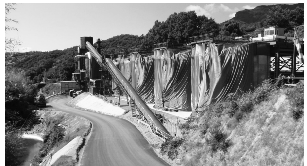
図-1 骨材貯蔵・輸送、コンクリート製造設備全景写真
