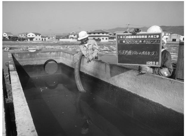
図-3 場所打ち杭施工後汚泥処理
